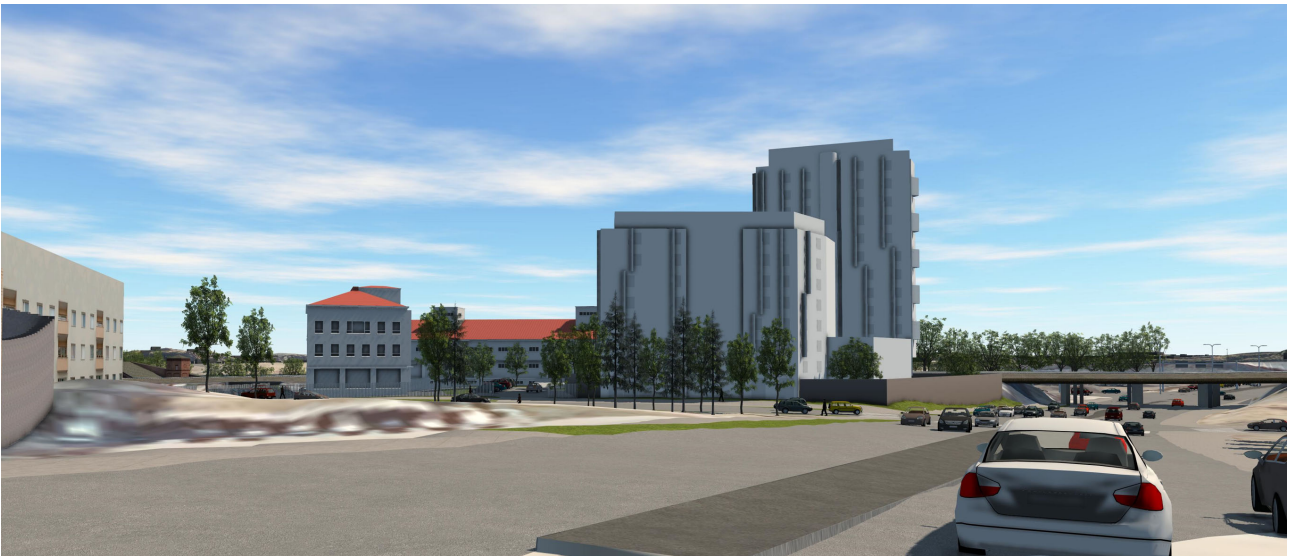
Näkymä Päiviönkadulta. Uudet rakennukset sijoittuvan tontilla sen länsiosaan (kuvassa oikealla). Hankkijan entinen varistorakennus näkyy osittain ja toimisto-osa näkyy kokonaan Päiviönkadulle.
