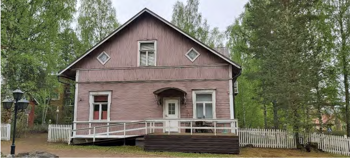
Kuva 15 Rakennuksen julkisivu pohjoiseen Haukivuoren torin suuntaan.
