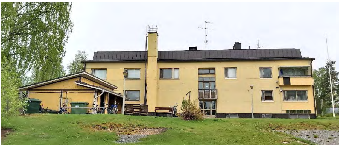
Kuva 4 Osuuskassan liiketalon julkisivu länteen sisäpihan suuntaan, myös talousrakennus.
