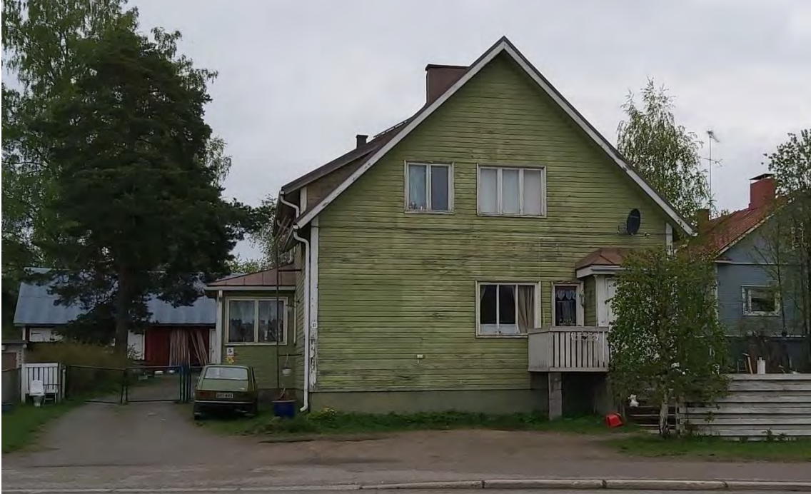
Kuva 81 Entisen osuuskassan itäinen julkisivu Keskustien suuntaan.
