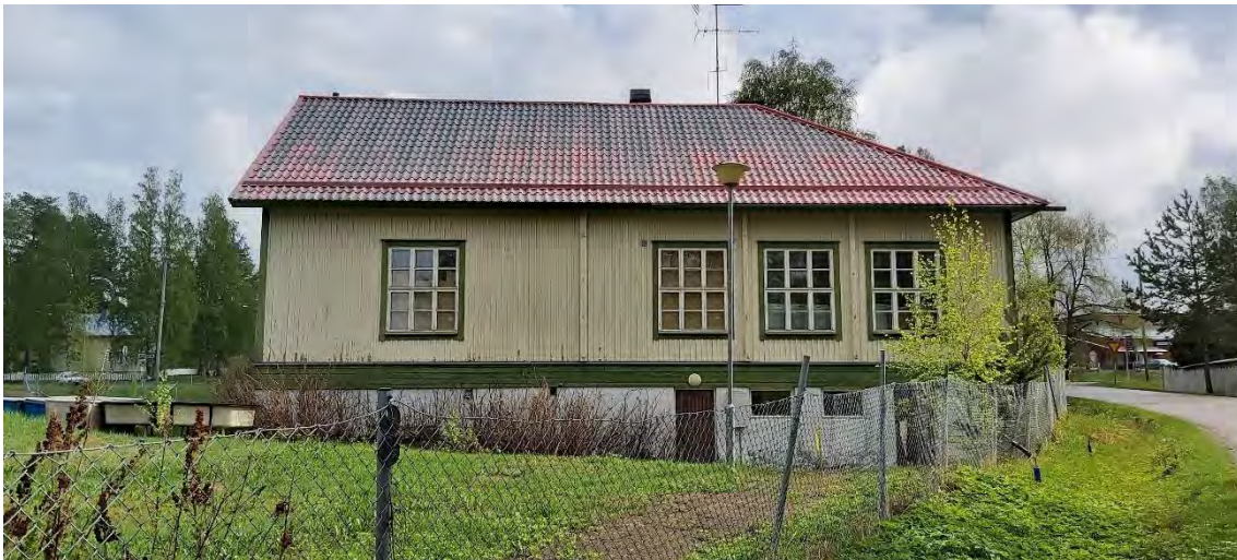
Kuva 34 Entisen kansakoulun ja nuorisotalon julkisivu länteen.
