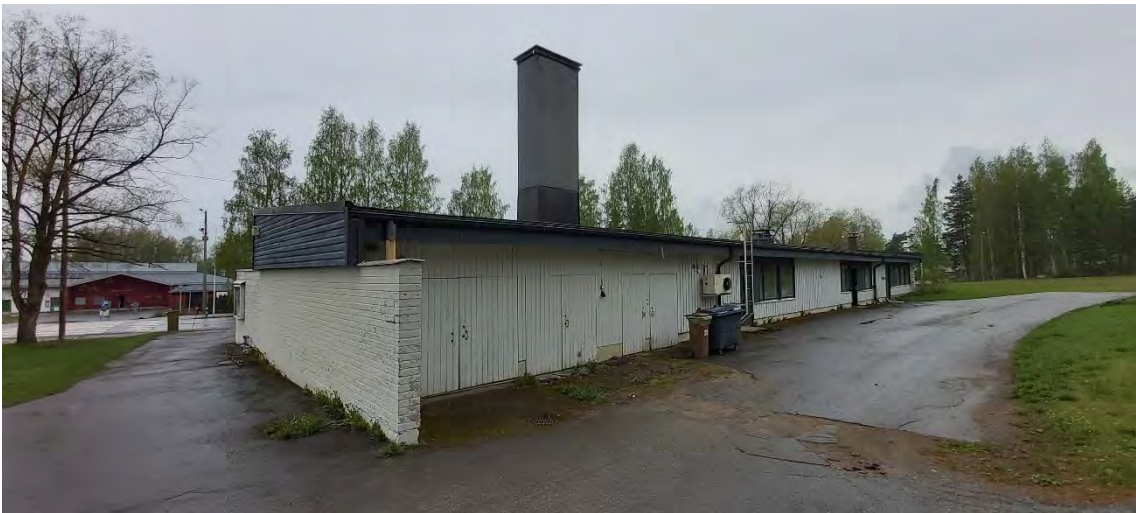
Kuva 26 Seurakuntatalon eteläistä julkisivua pysäköintialueen suuntaan sekä sisäpihan puoleinen julkisivu.
