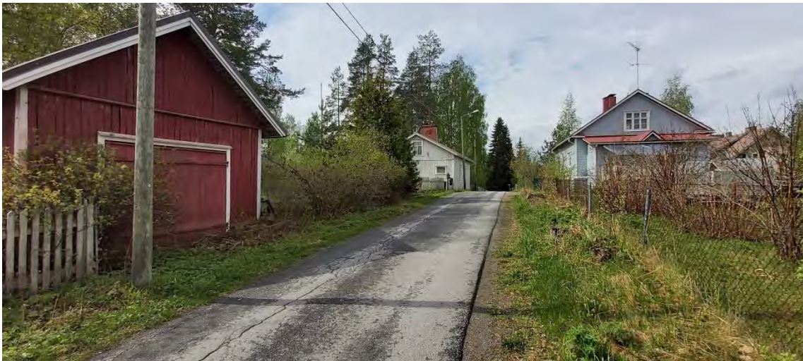
Kuva 73 Osittain kujannetta rajaavat puut ja pensasaidat sekä metalliverkosta rakennettu aita. Puutalomiljöööhön kuuluu varsinaisesti Välttien varrella vain muutama rakennus. Kuvassa kujamiljööötä länteen päin kuvattuna.
