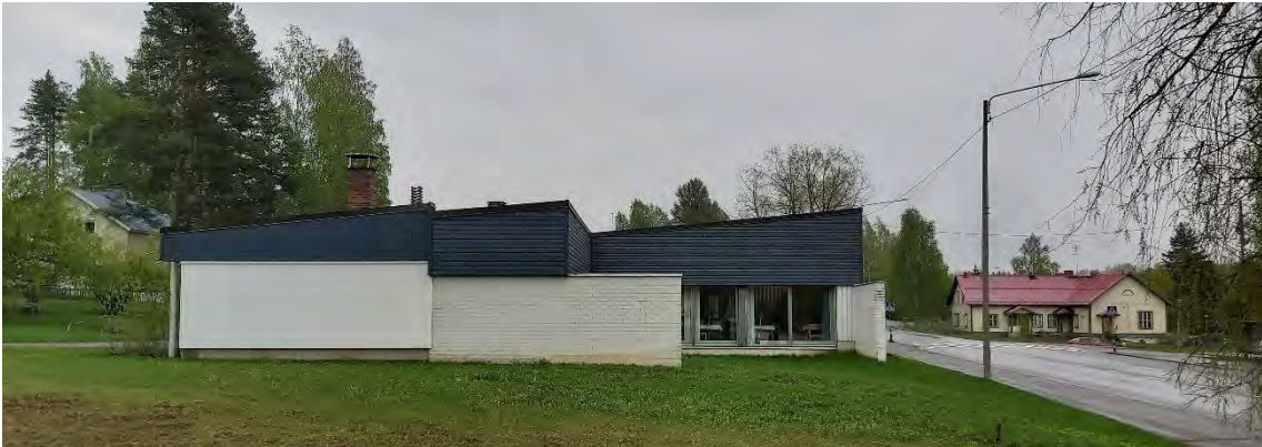
Kuva 25 Seurakuntatalon julkisivu pohjoiseen Haukivuoren torin suuntaan.
