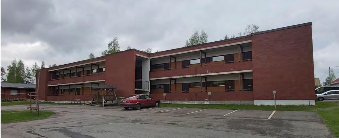
Kuva 86 Taloyhtiö Työkulman julkisivu itään Suojatien suuntaan. Horisontaalista rakennusta on rytmitetty murroksella, joka jakaa rakennuksen kahteen siipeen.
