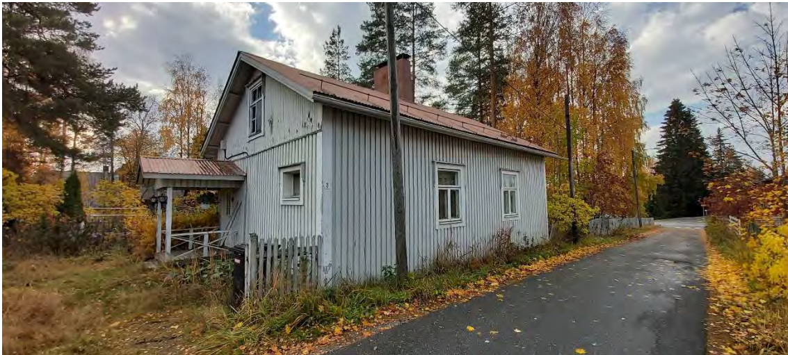
Kuva 99 Rakennuksen itäistä julkisivua pihan suuntaan ja pääjulkisivua pohjoiseen Suojatien suuntaan.
