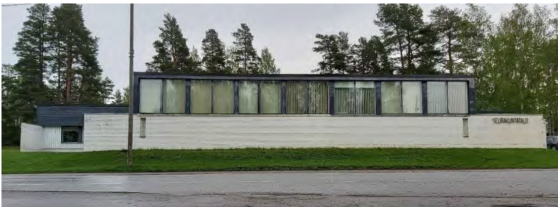
Kuva 23 Seurakuntatalon pääjulkisivu länteen Keskustien suuntaan.
