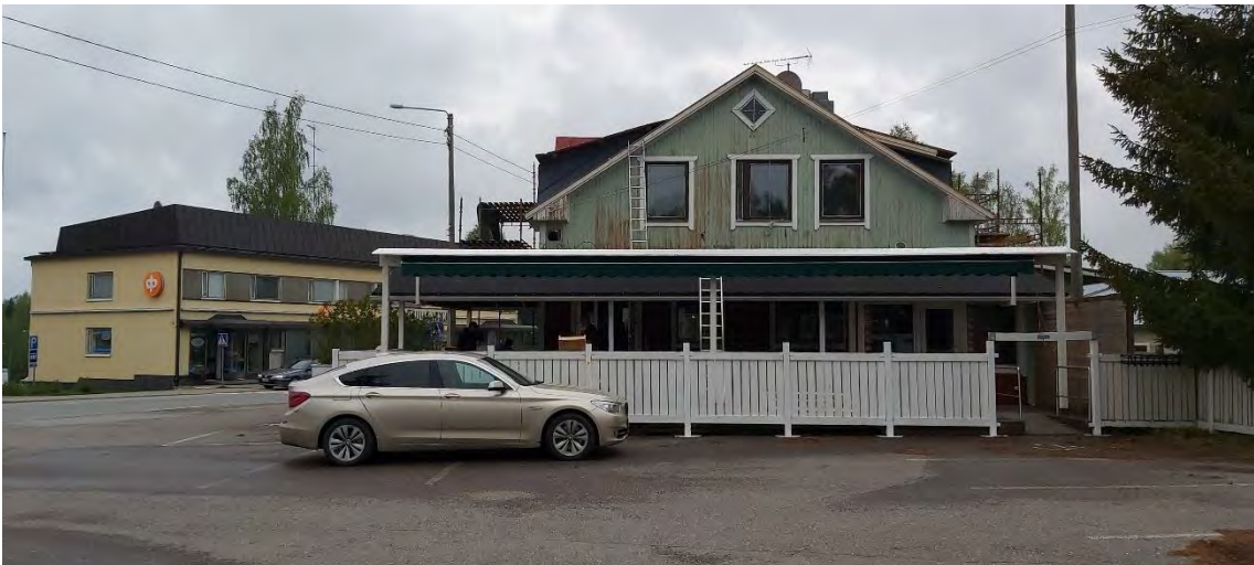
Kuva 56 Rakennuksen julkisivua etelään aukion suuntaan. Rakennuksen edustalle on rakennettu katettu terassiosuus.
