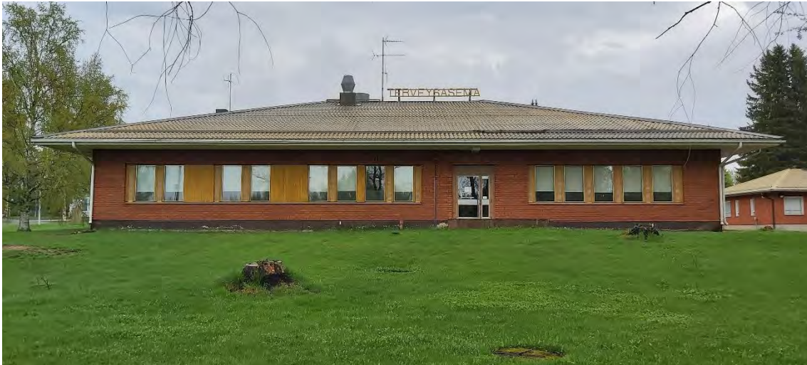
Kuva 46 Entisen terveysaseman pääjulkisivu länteen Keskustien suuntaan.
