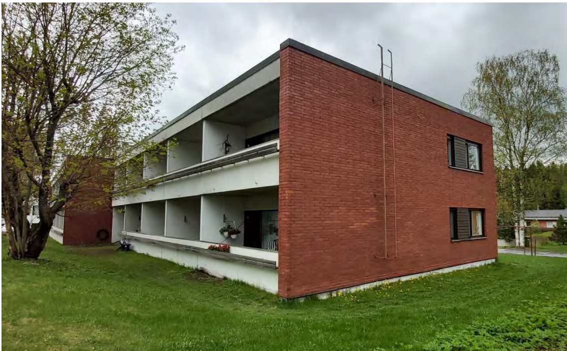
Kuva 89 Rakennuksen eteläinen pääty sekä länteen avautuvat nauhaparvekkeet.
