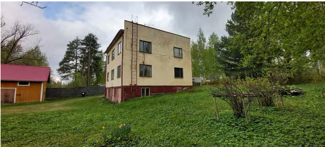
Kuva 21 Keskustie 56:n julkisivu etelään pihan suuntaan.
