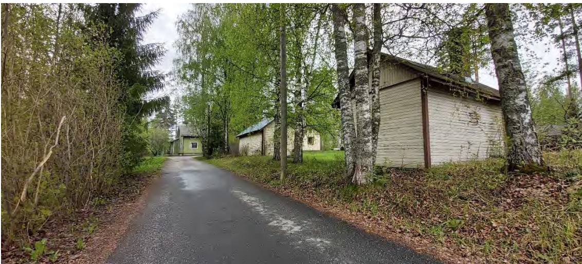
Kuva 94 Suojatietä kuvattuna etelään päin. Vihreä puurakennus muodostaa päätteen Suojatien näkymässä. Tietä rajaavat osin rakennukset, osin kasvillisuus ja aidat.
