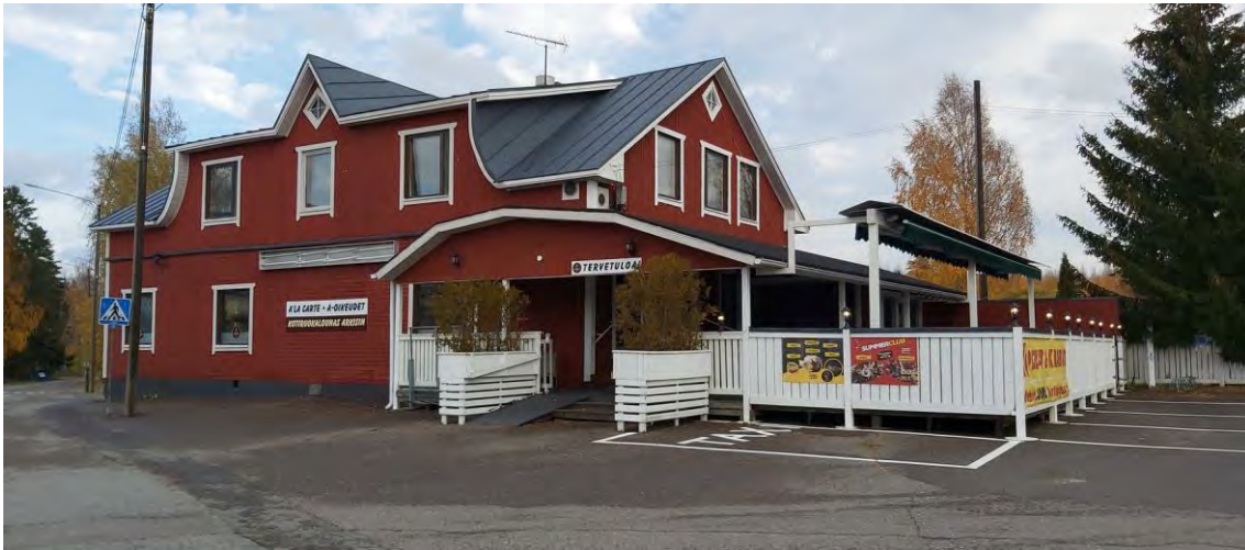
Kuva 60 Rakennus kunnostutöiden jälkeen uudessa julkisivuvärytyksessään.
