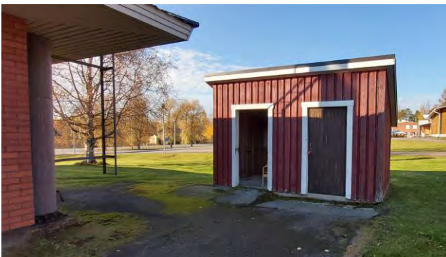
Kuva 50 Kiinteistöllä sijaitseva jätekatos.
