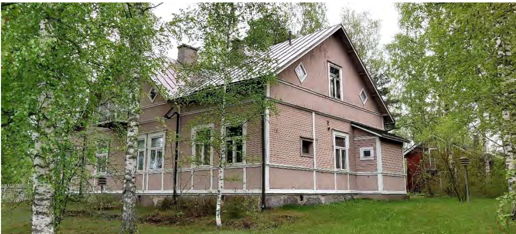
Kuva 16 Rakennuksen eteläinen pääty ja pääjulkisivua. Nähtävissä alkuperäinen kivijalka ja taustalla punamullattua piharakennusta.
