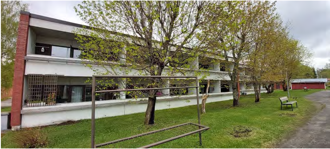
Kuva 88 Rakennuksen läntinen julkisivu, jossa sijaitsevat asuntokohtaiset parvekkeet.
