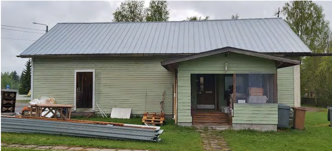
Kuva 57 Kunnostuksen kohteena oleva talousrakennus (2007) pihapiiriä rajaamassa. Julkisivu etelään.
