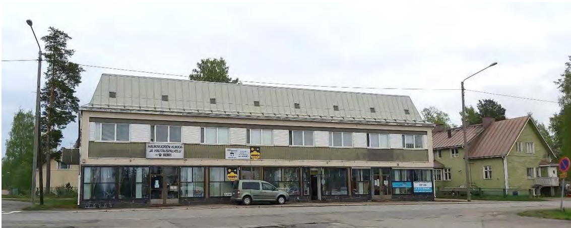
Kuva 9 Entisen Säästöpankin pääjulkisivu länteen Keskustien suuntaan.
