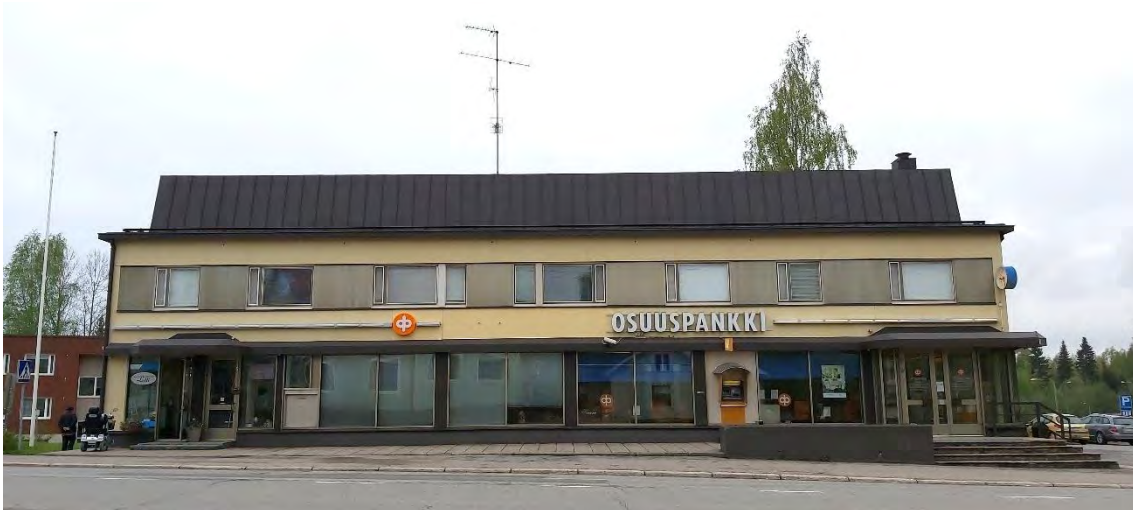
Kuva 3 Osuuskassan liiketalon pääjulkisivu itään Keskustien suuntaan.
