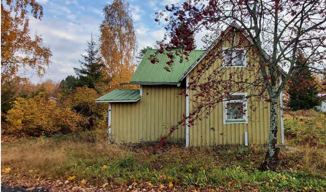
Kuva 104 Rakennuksen pääjulkisivu länteen Suojatien suuntaan.
