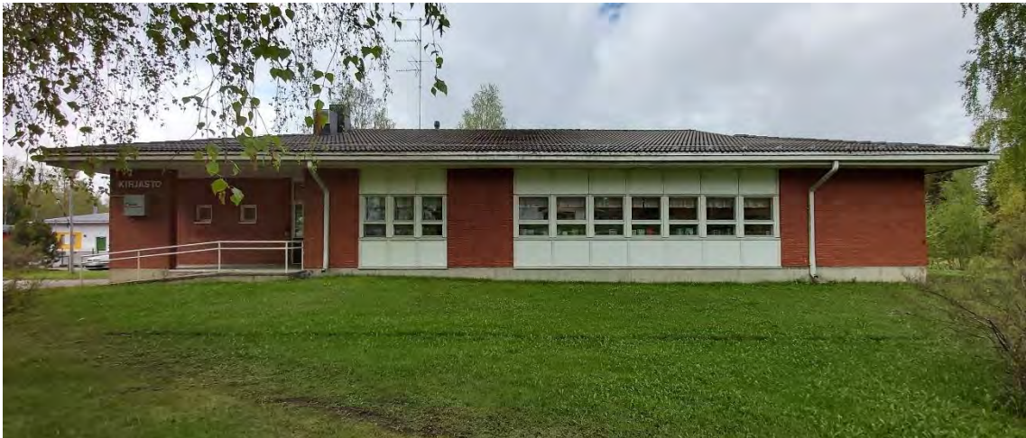
Kuva 28 Kirjaston julkisivu itään Keskustien suuntaan.
