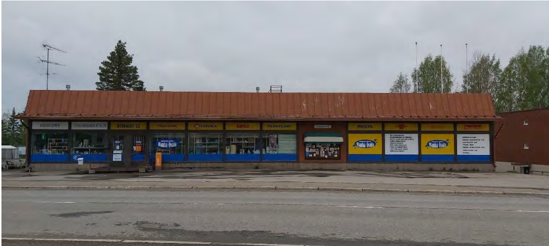
Kuva 61 Wanhan Osulan pääjulkisivu itään Keskustien suuntaan.
