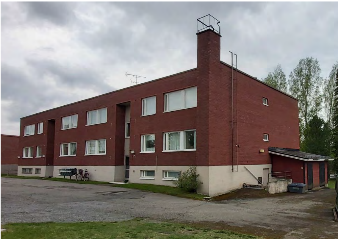
Kuva 92 Rakennuksen julkisivut itään Keskustien suuntaan sekä päätyjulkisivu pohjoiseen.
