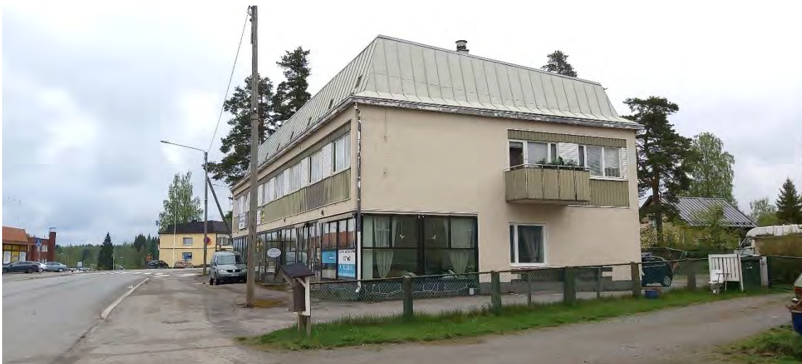
Kuva 12 Rakennuksen eteläinen julkisivu, jossa parveke.
