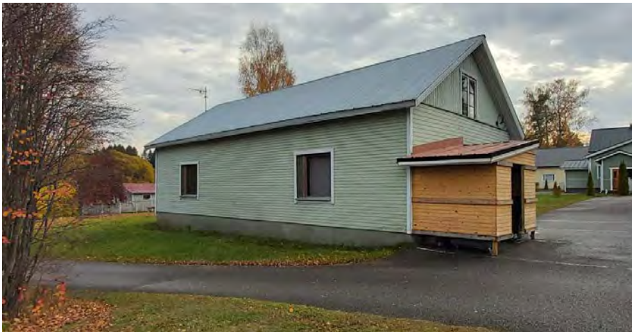
Kuva 58 Talousrakennuksen julkisivua pohjoiseen ja länteen.
