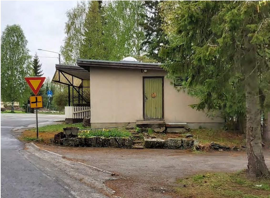
Kuva 80 rakennuksen julkisivu itään. Taustalla Keskustien ja Haukivuorentien risteysaluetta.
