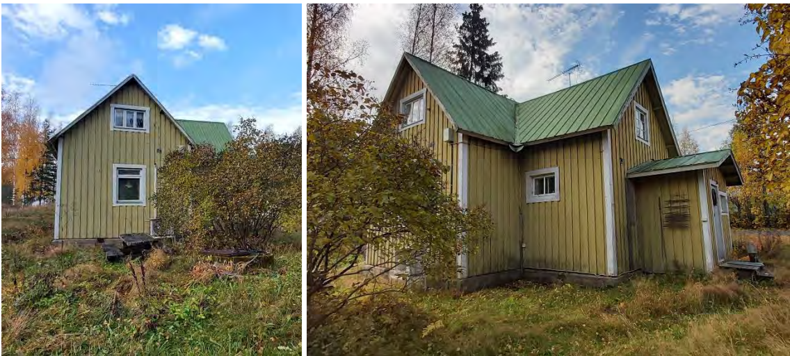
Kuvat 107 ja 108 Rakennuksen julkisivu itään ja koilliseen pihan suuntaan.
