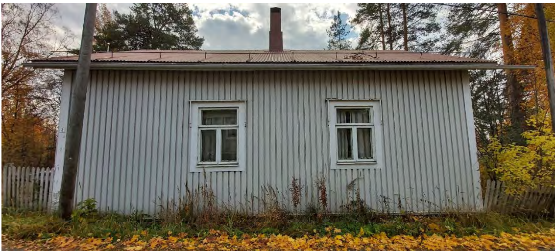
Kuva 100 Rakennuksen pääjulkisivu pohjoiseen Suojatein suuntaan.
