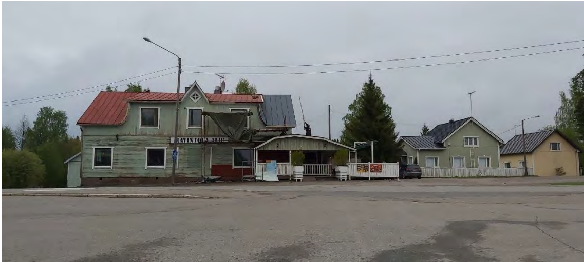
Kuva 53 Rakennuksen pääjulkisivu länteen Keskustien ja torin suuntaan suuntaan. Rakennuksen julkisivuja kunnostetaan parhaillaan kuvien ottamishetkellä 18.5.2021.
