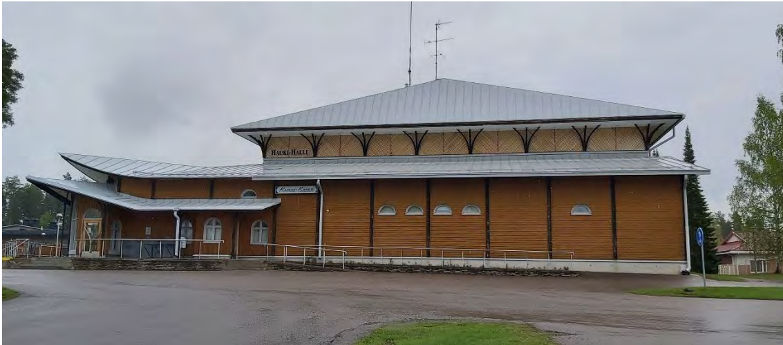
Kuva 41 Hauki-Hallin julkisivu länteen Keskustien suuntaan.
