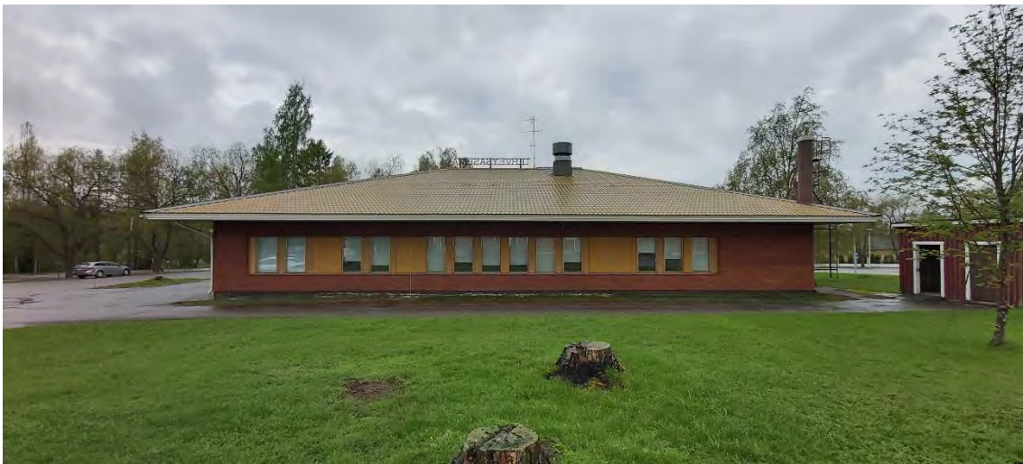
Kuva 47 Rakennuksen julkisivu itään.
