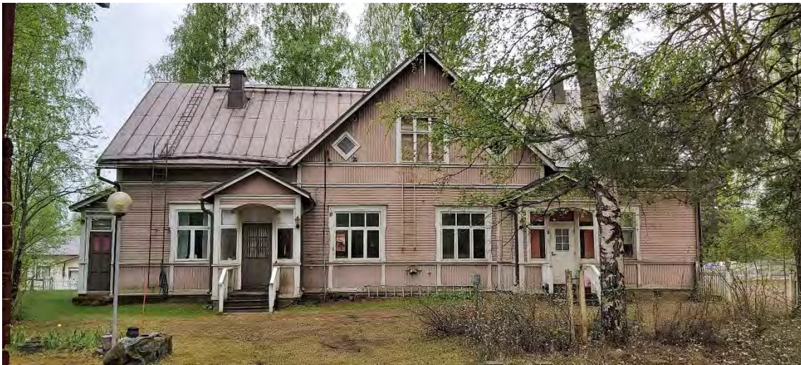
Kuva 13 Rakennuksen julkisivu sisäänkäynteineen itään päin sisäpihan suuntaan.
