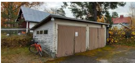
Kuva 10 Talousrakennus (1964) pohjoiseen ja länteen.
