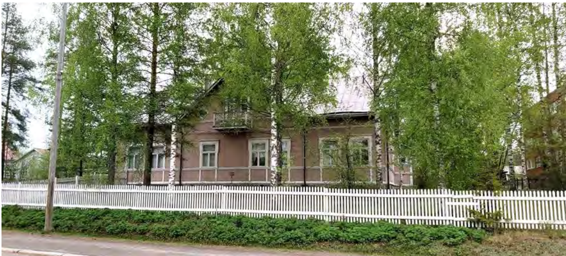
Kuva 14 Rakennuksen pääjulkisivu länteen Keskustien suuntaan peittyy kesäaikaan vehreiden koivujen taakse.
