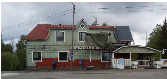
Kuva 59 Rakennuksen kunnostusta, julkisivut ja vesikatto uudistetaan.
