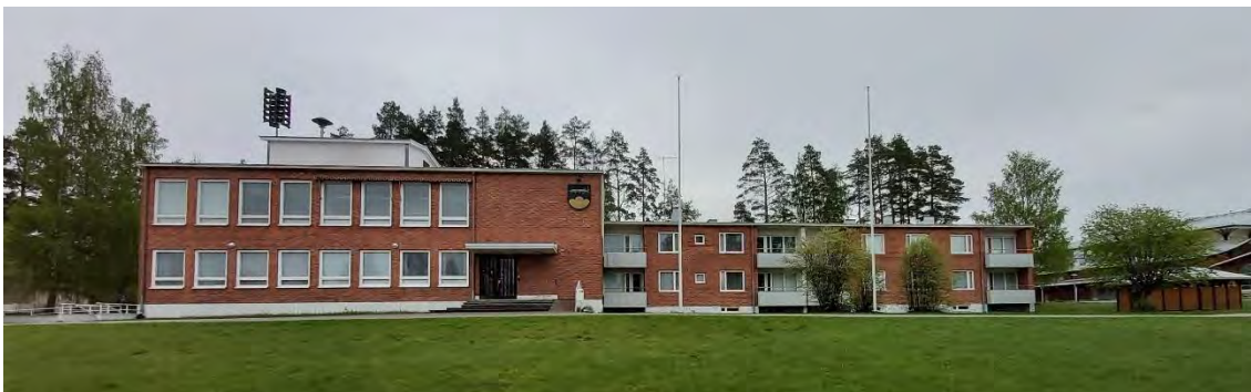
Kuva 35 Haukivuoren entisen kunnantalon, nykyisen Haukivuori-talon, pääjulkisivu Keskustien suuntaan
