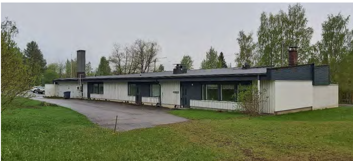
Kuva 24 Seurakuntatalon liiketalon julkisivu itään sisäpihan suuntaan sekä pohjoispäätä keskustan suuntaan.
