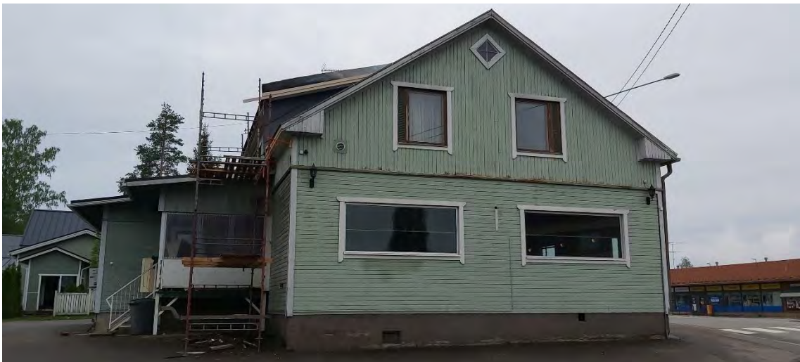
Kuva 54 Rakennuksen päätyjulkisivua pohjoiseen Haukivuorentien suuntaan.
