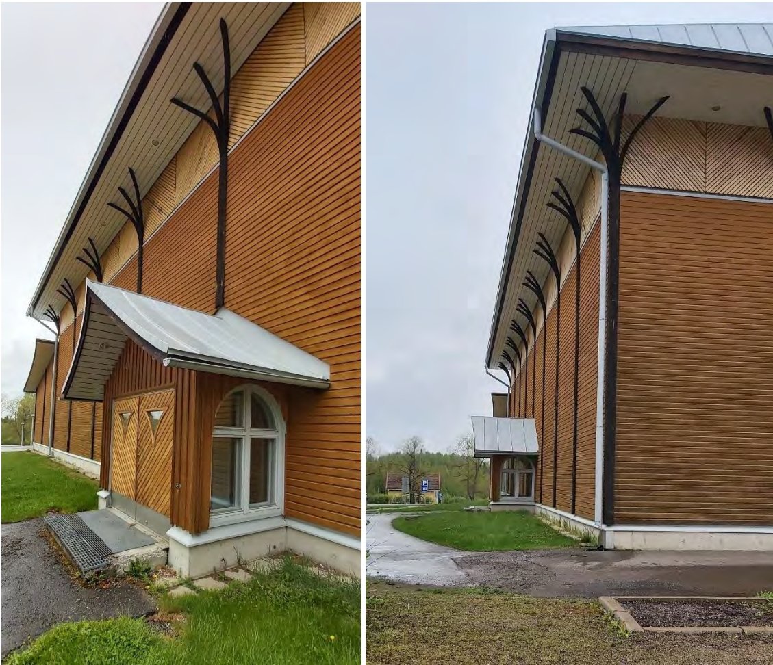
Kuvat 43 ja 44 Hauki-Hallin julkisivua etelään. Julkisivu on umpinainen ja sen keskivaiheilla on katettu sisäänkäynti.
