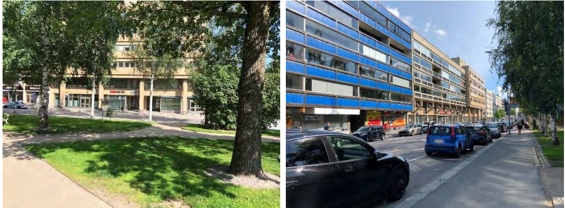
Kuva 22. (vas.) Inventoinnin kohteena oleva rakennus Kirkkopuistosta katsottaessa. Kuva 23. (oik) Porrassalmenkadun katujulkisivua. Liiketilat sijaitsevat katutasossa. Porrassalmenkatu 29 hahmottuu ulokkeena viereisistä rakennuksista ja on linjassa viereisen Porrassalmenkatu 31 ulokkeen kanssa. Porrassalmenkatu 31 sijaitsevalla Kiinteistö Oy Savilahdenpuistolla on omaleimaiset tukirakenteet. Porrassalmenkatu 33 kiinteistössä on voimakkaansiniset parvekekaiteet.
