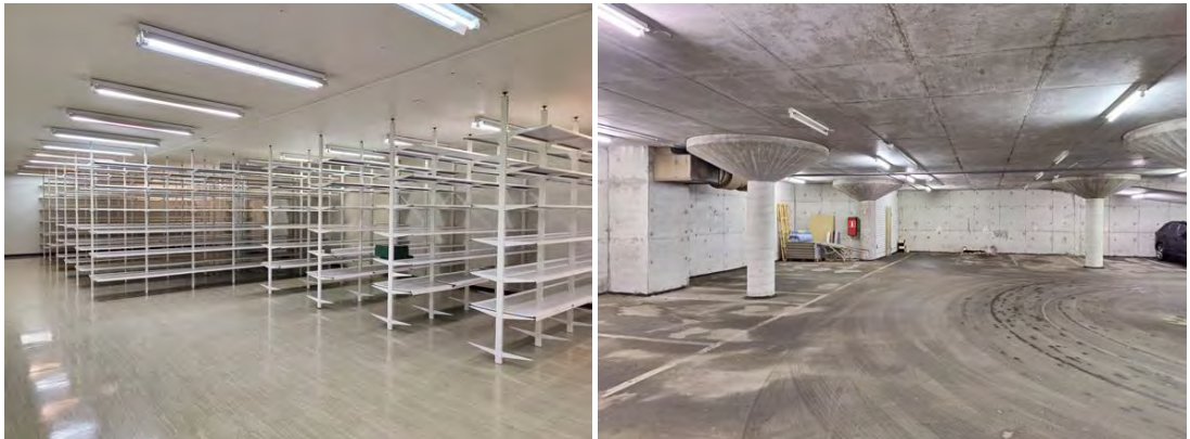
Kuva 28. (vas.) Arkisto kellarikerroksessa K1. Kuva 29. (oik.) Pysäköintitilat kellarissa K2. Sienimäiset pilarit toimivat tilan kantavana rakenteena.
