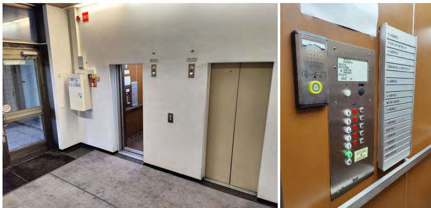
Kuva 35. Hissiaula katutasokerroksessa. Vaalea värимаailma toistuu myös rakennuksen sisätiloissa. Kuva 36. (oik.) Tarkempi kuva hissien varusteista. Hissi on Koneen valmistama ja siinä on vuosiluku 1981.
