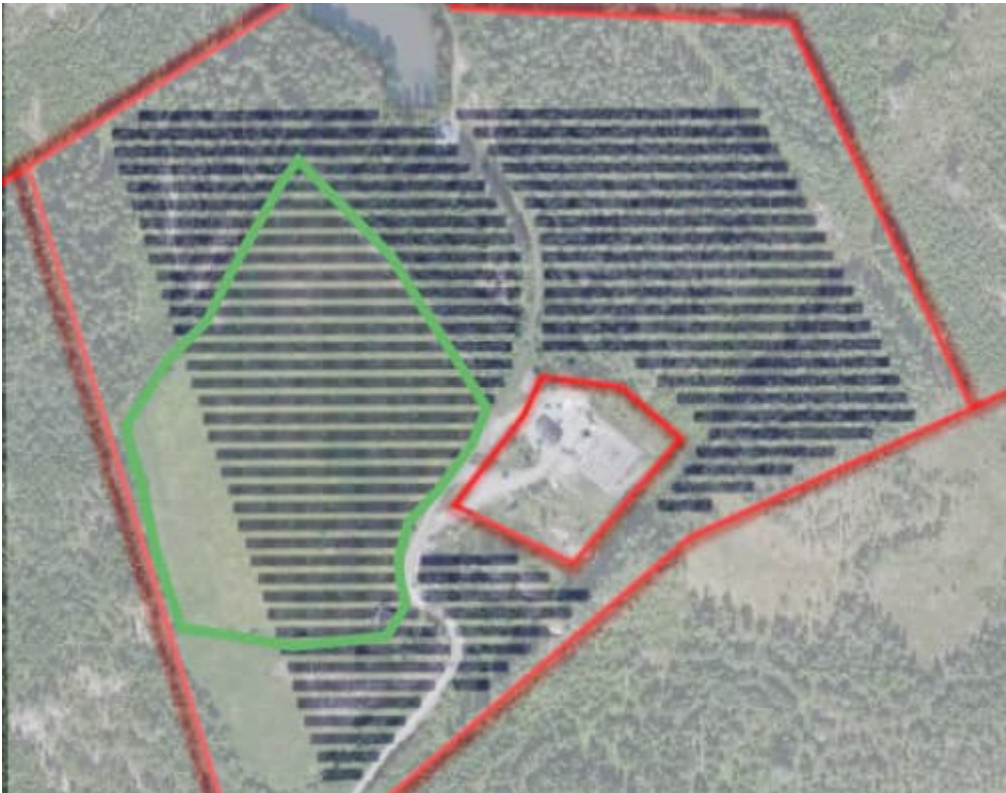
Kuva 1. Ristiinan aurinkovoimalan sijainti kaatopaikkaan nähden. Suljetun yhdyskuntajätteen kaatopaikan rajaus on esitetty vihreällä.
