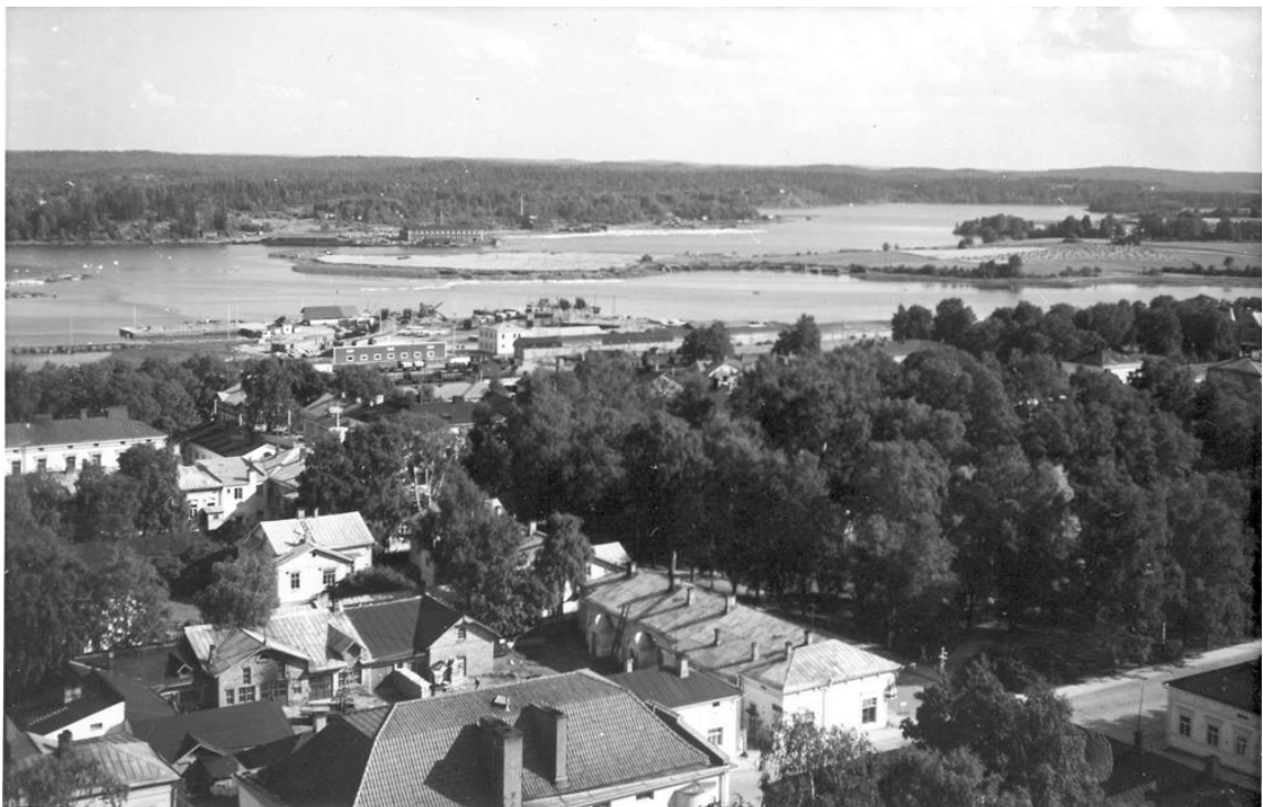
Kuva 2. 1800-luvulla rakennettuja puutaloja suunnittelualueella. Näkymä Naisvuorelta kohti Kirkkopuistoa. Kuva: Mikkelin museoiden valokuva-arkisto
