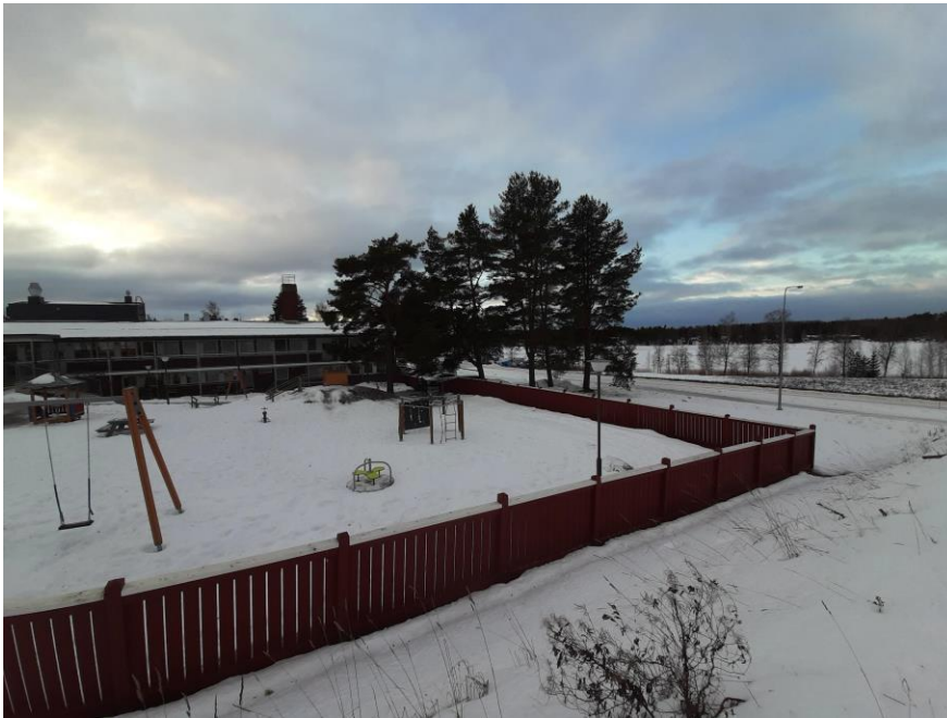
Kuva 17. Kuvassa näkyy entisen Ristiinan päiväkodin pohjoispuolella sijaitsevat kaavamuutoksessa säilytettävät maisemallisesti arvokkaat männyt.
