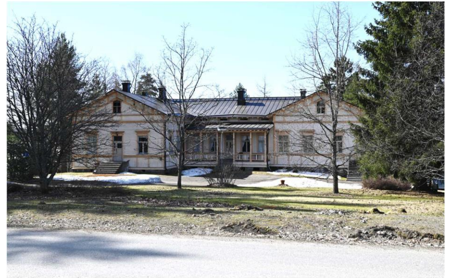
Kuva: Entinen kansakoulutalo 1880-luvulta. Ulko-ovet ja betoniportaatt ajoittunevat 1900-luvun keskivaiheilla, ja ikkunoissa on saattanut olla alun perin jakopuitteita. Avoveranta on palautettu 2010-luvulla.
