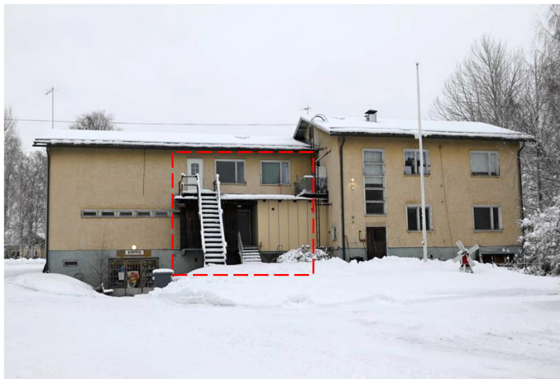
Kuva: Julkisivu länteen. Lastaussillan kohta on kokenut muutoksia. Kellarikerroksen varastotila on liikekäytössä.
