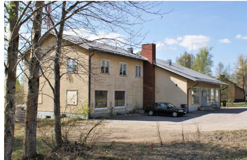
Kuva: Osuuskauppatalo on lautarunkoinen ja rapattu. Asuntopuolelta on alakerroksen ikkunoita suurennettu ja toimistohuoneen sisäänkäynti poistettu.
