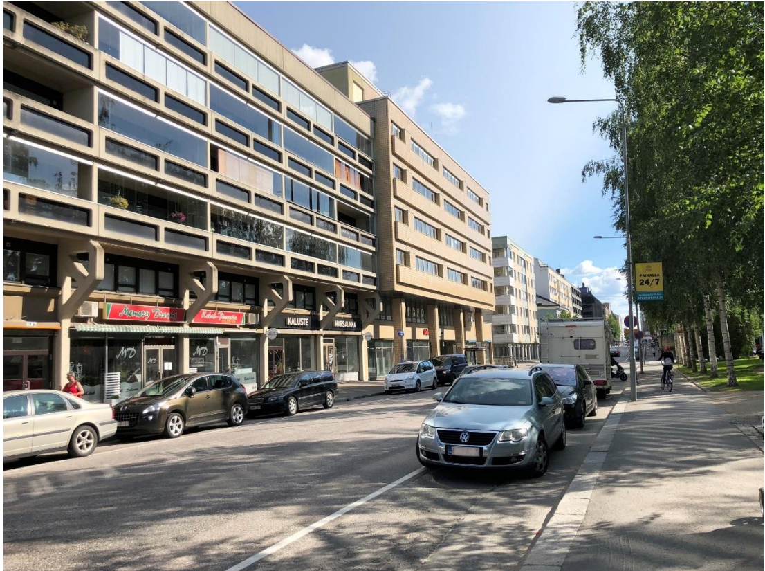
Kuva 6 Porrassalmenkatu 29 liike- ja toimistorakennus on osa yhtenäistä Porrassalmenkadun katujulkisivua. Korttelissa 1 rakennusten ensimmäiset kerrokset ovat sisäänvedetyt, ja katutilaan muodostuu arkadikäytävä. Porrassalmenkatu 29 julkisivu työntyy naapurirakennuksia enemmän katutilaan ja muodostaa ulokkeen.
