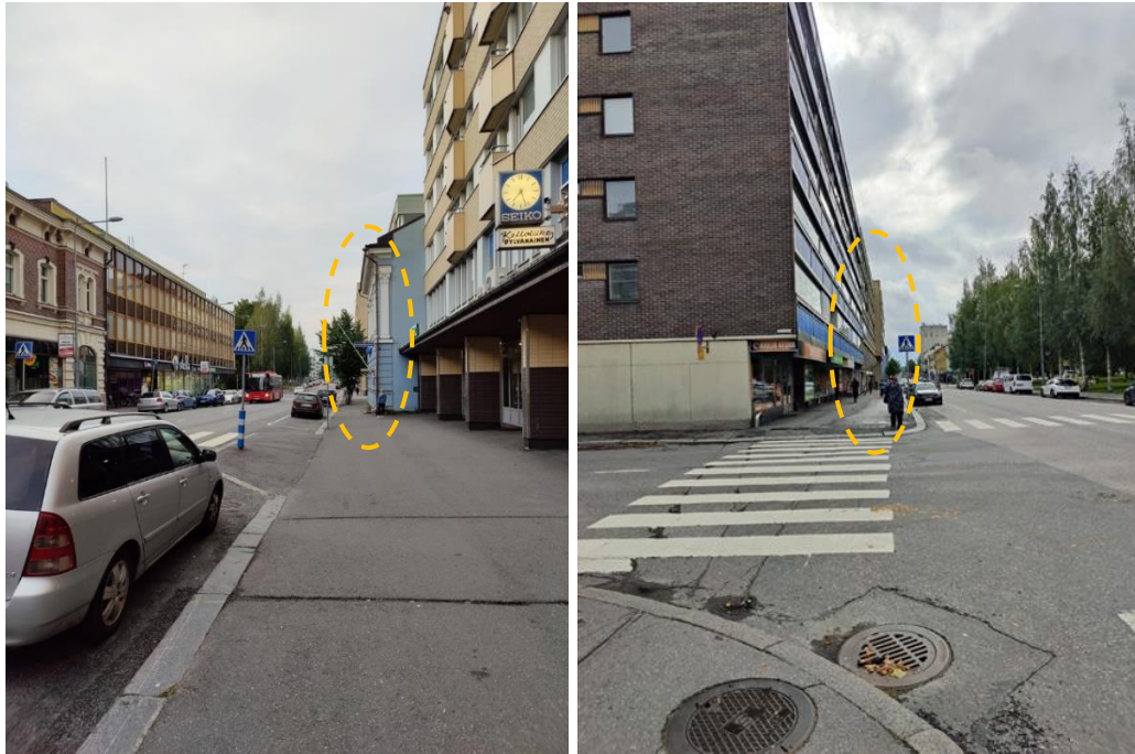
Kuva 41. (vas). Näkymä Savilahdenkadulta etelästä kohti konttorirakennusta. Uloke näkyy vaaleansinisen rakennuksen jälkeen. Kuva 42. (oik). Rakennus Savilahdenkadulla pohjoisesta katsottuna. Kohde esitetty keltaisella katkoviivalla.
