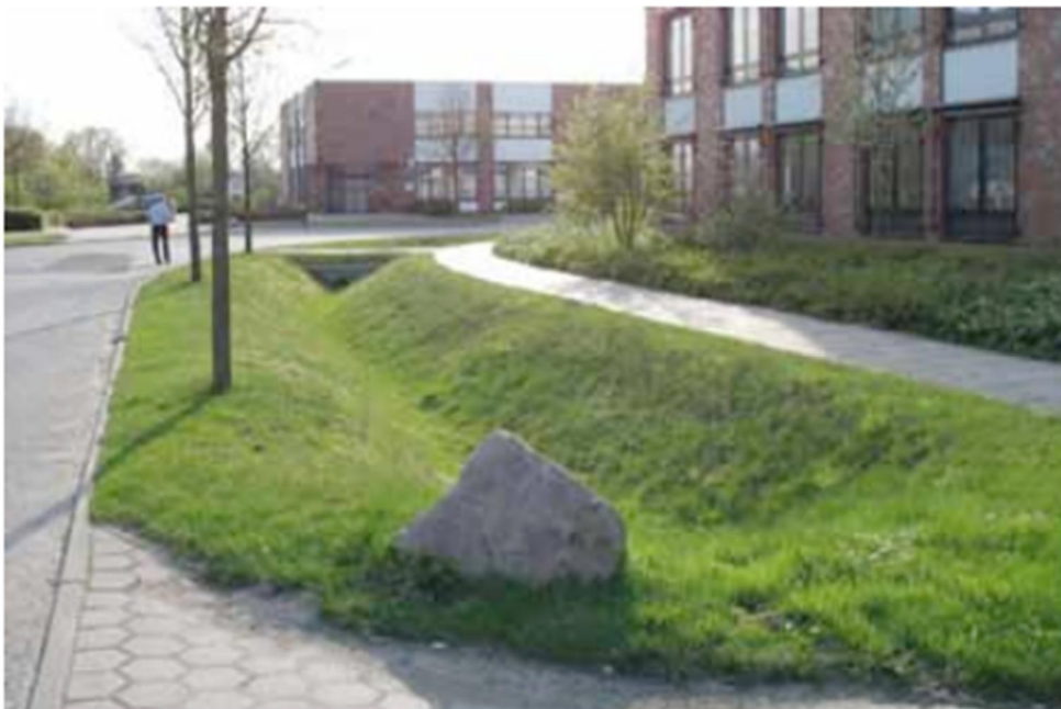
Kuva 12. Esimerkkikuva viherpeitteisestä ojasta (Hulevesiopas 2012)
