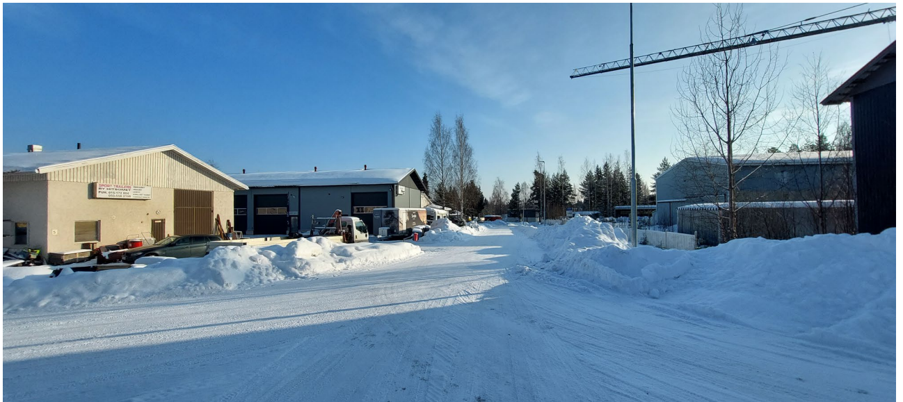
KUVA 4 alueen teollisuus- ja toimitilarakennuksia Temmikadun varrella
