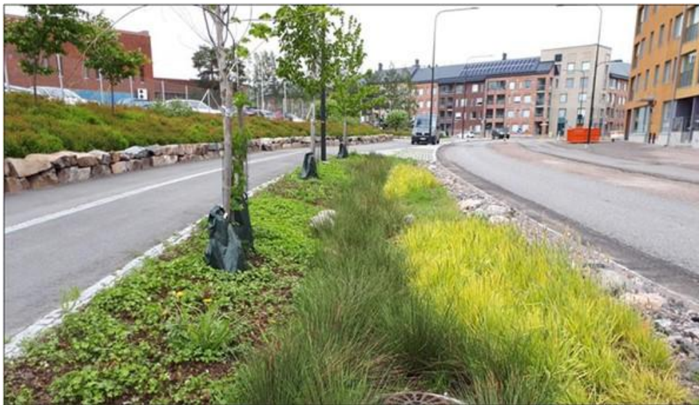
Kuva 10. Esimerkki biosuodatusrakenteesta (© Ramboll)
