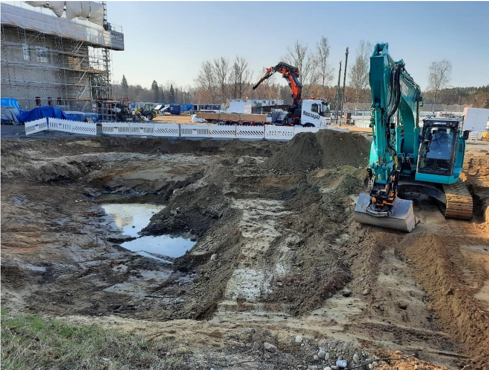
Kuva 8. Saimaanportin yhtenäiskoulun pilaantuneen maan kaivu keväällä 2023
