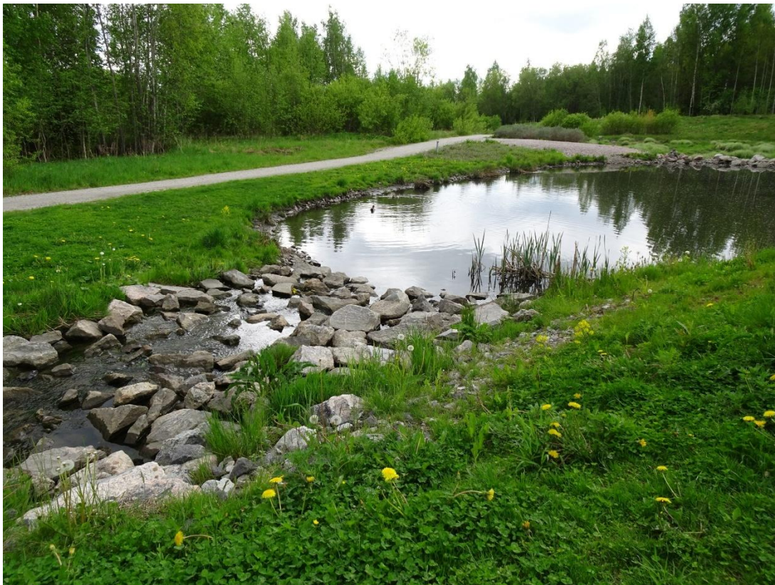
Kuva 6. Esimerkkikuva viivytsaltaasta (© Päijät-Hämeen vesijärvisäätiö)
