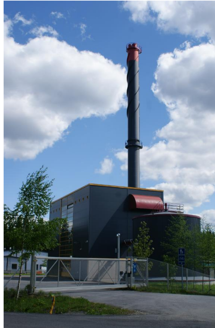
Kuva: Rokkalan lämpökeskus valmistui vuonna 2004.
