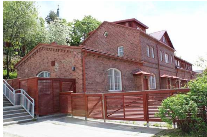
Kuva: Savonlinnan kunnallinen sähkölaitos Haislahden rannalla, peruskorjattu asunnoiksi.
