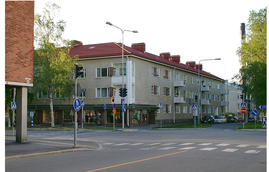
Kuva: Satoaukion liike- ja asuinkerrostalo Savilahdenkadun ja Runeberginaukion kulmauksessa (piirtänyt 1953).
