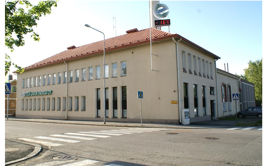
Kuva: Vanhaan konehuoneeseen 1970-luvulla tehdyt ikkunamuutokset (korkeat syvennykset) pyrittiin sovittaman rakennuksen pelkistettyyn tyyliin.
