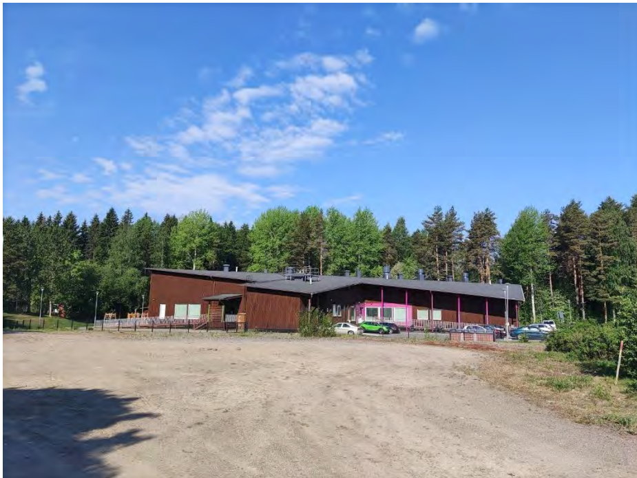
Kuva: Vuonna 2019 valmistunut Kattilasillan päiväkotitoiminta hallitsee tällä hetkellä kaupunkikuvaa. Tyhjä avoin kenttä odottaa rakentamista.
