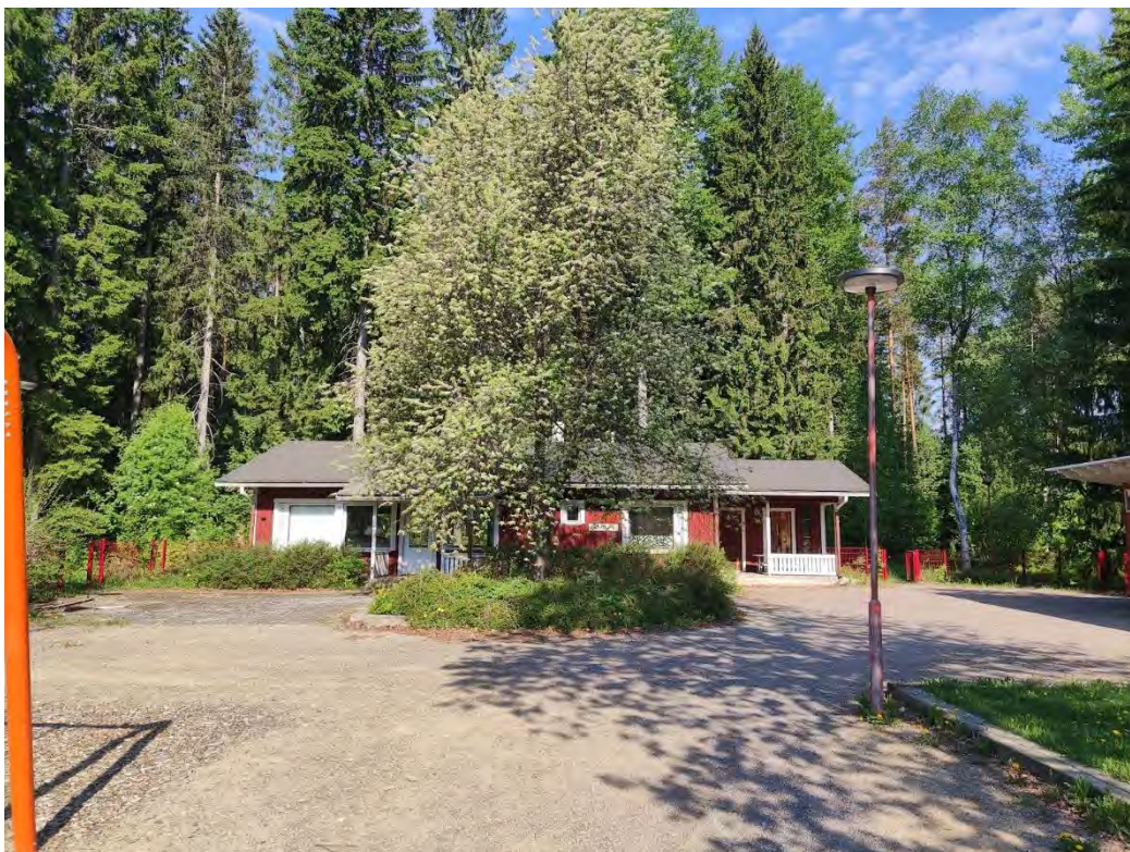
Kuva: Leikkipuistossa sijaitseva huonokuntoinen Punapirtti on tarkoitus purkaa tulevaisuudessa.
