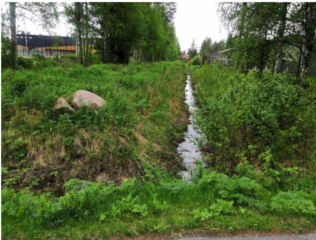
Kuva 9. Esimerkki avo-ojasta (Ramboll)
