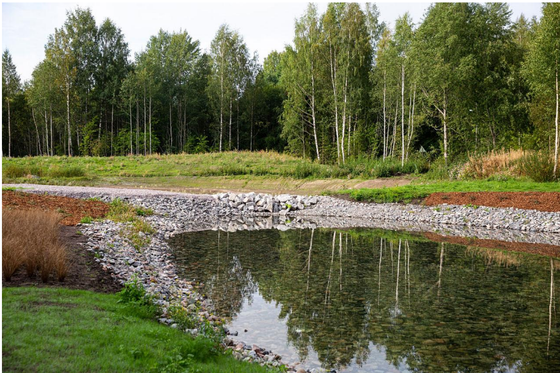
Kuva 5. Esimerkki viivytyksaltaasta (© Vesi.fi)
