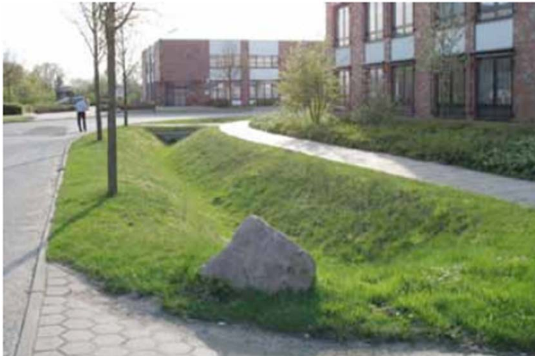
Kuva 8. Esimerkkikuva viherpeitteisestä ojasta (Hulevesiopas 2012)
