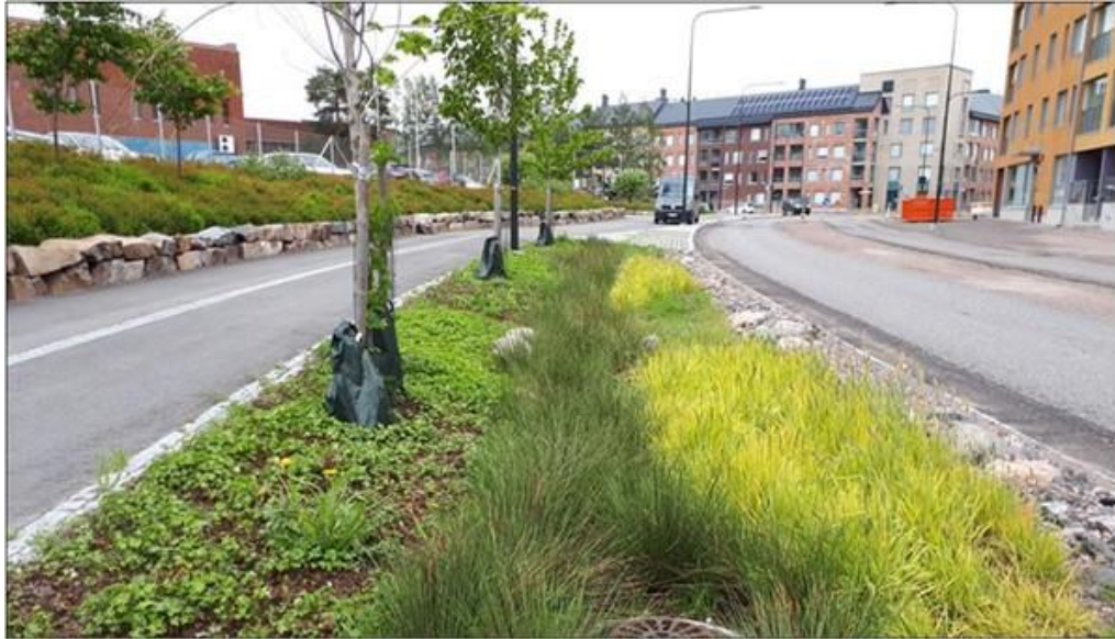
Kuva 10. Esimerkki biosuodatusrakenteesta (© Ramboll)
