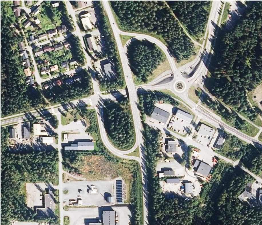
Kuva 20: Ortokuva Tuskun eritasoliittymästä. (MML Ortokuva)
