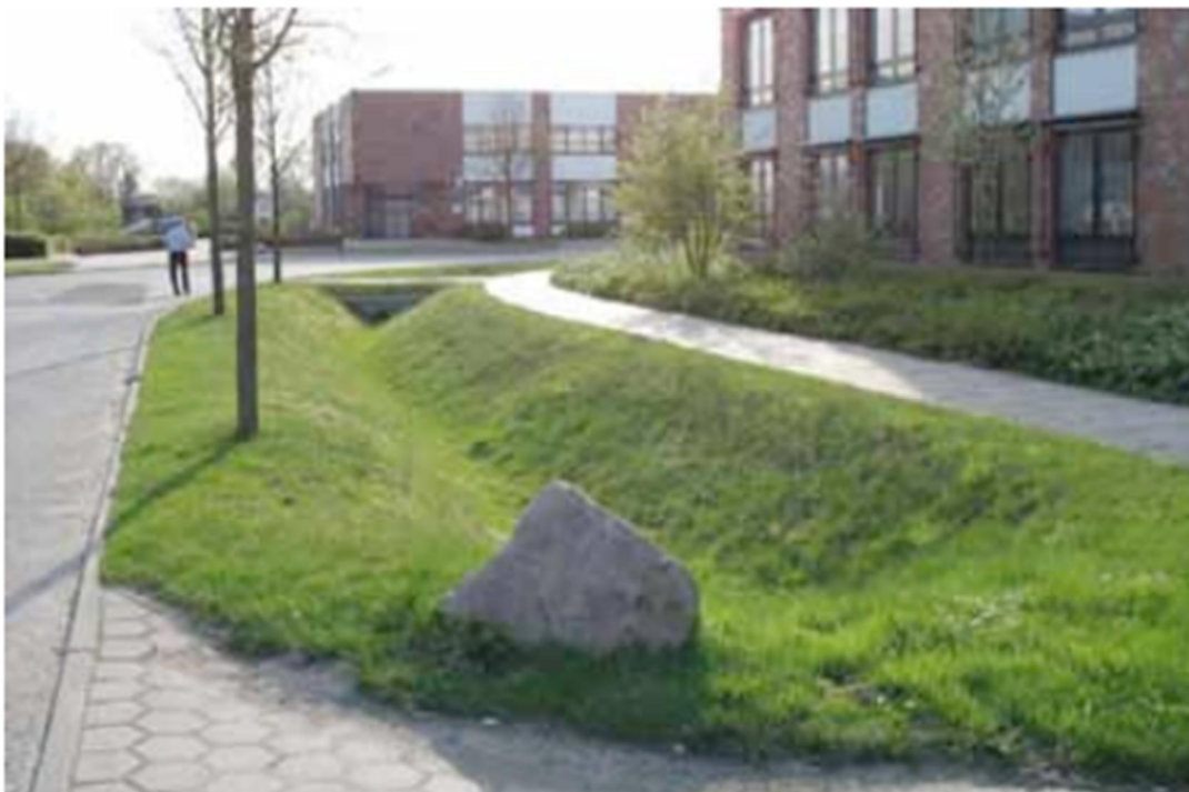
Kuva 16. Esimerkkikuva viherpeitteisestä ojasta (Hulevesiopas 2012)
