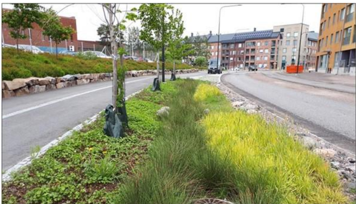
Kuva 14. Esimerkki biosuodatusrakenteesta (© Ramboll)
