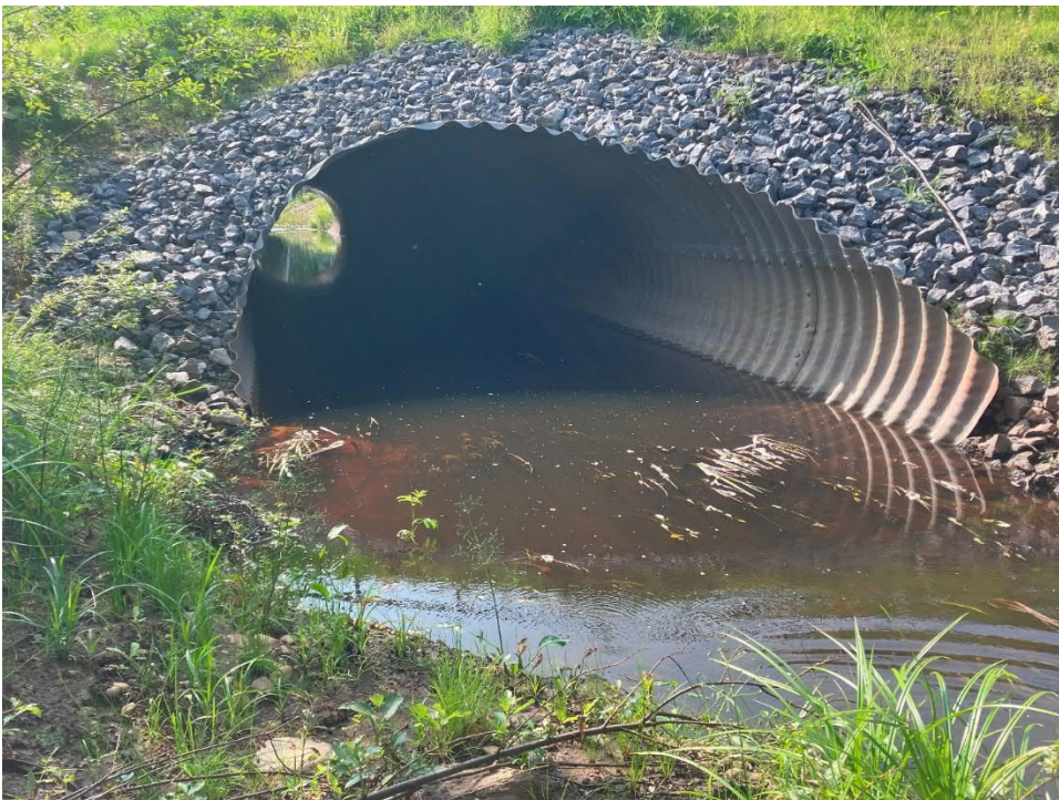
Kuva 10: Valtatie 13 ylittää Siekkilänjoen teräsputkisillalla Lentokentänkadun liittymän eteläpuolella.
