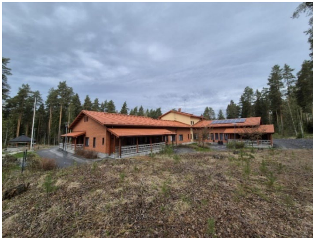
Kuva: Suunnittelualan pohjoispuolella sijaitseva punatiilinen palvelutalo.
