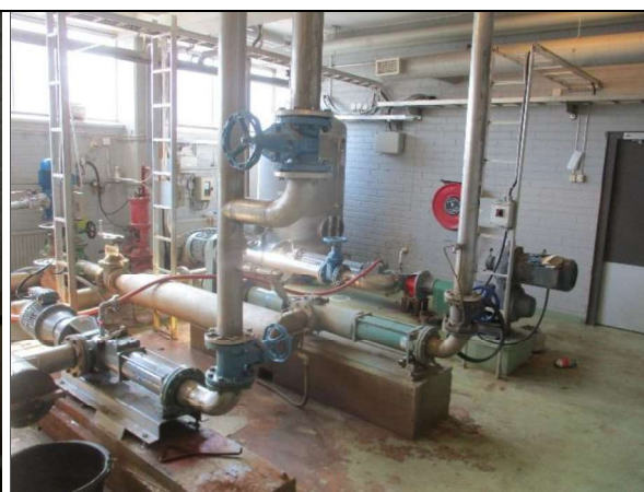
RM.02, RAK.14, pumppuhuone, lattianpinnoite
