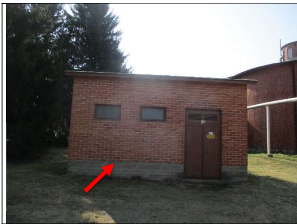
ASB.12, RAK.22, sokkeli-tiili, bitumikermi
