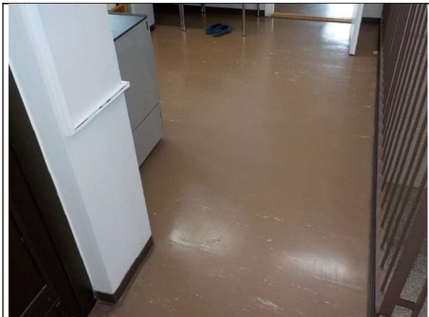
ASB.25, Valvomo, vinyylilaatta, ruskea
