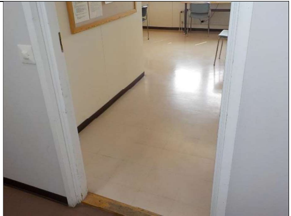
ASB.23, Valvomo, vinyylilaatta, vaalea
