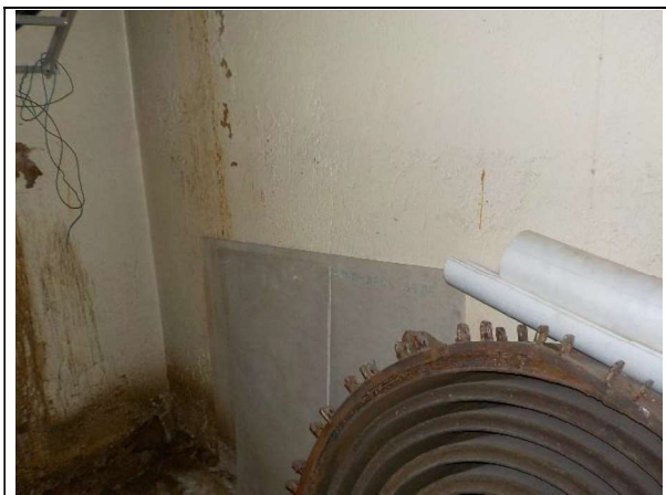
Irtonainen sementtikuitulevy pohjakerroksessa
