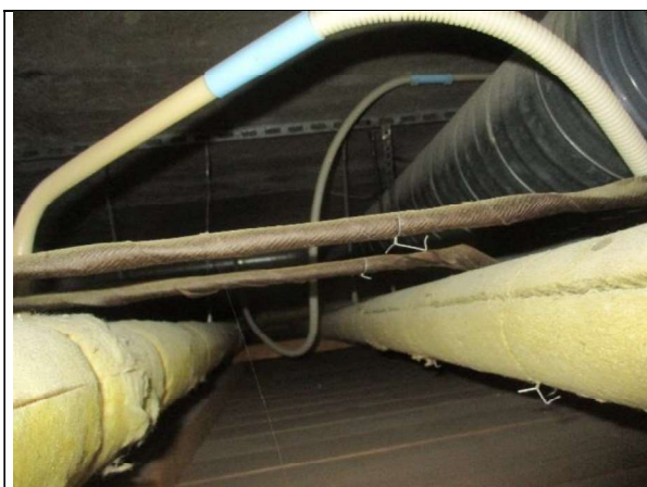
ASB.24, Valvomo, Putkieristepahvi
