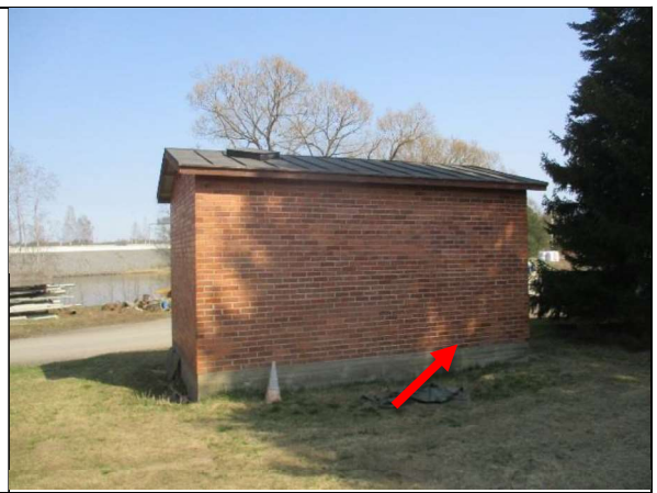
ASB.12, RAK.22, sokkeli-tiili, bitumikermi
