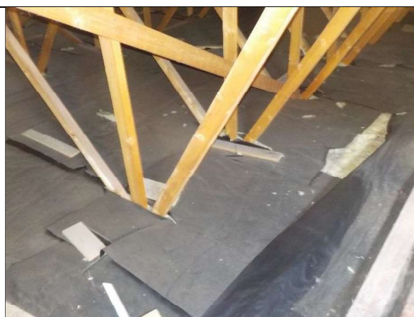
ASB.26, Valvomo, Yläpohja, tervapaperi
