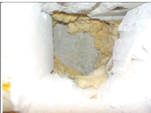
Yleiskuva maanvastaisen seinän rakenneavauksesta
