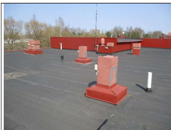
ASB.01, bitumikermi, vesikate, kokoomanäyte
