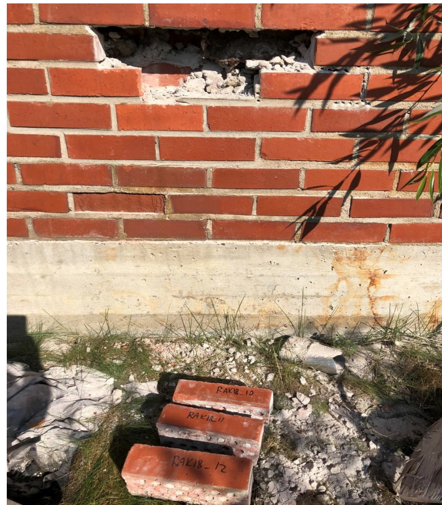
Kuva 8, Rakennuksen 18 eteläjulkisivun näytteenottopaikka
