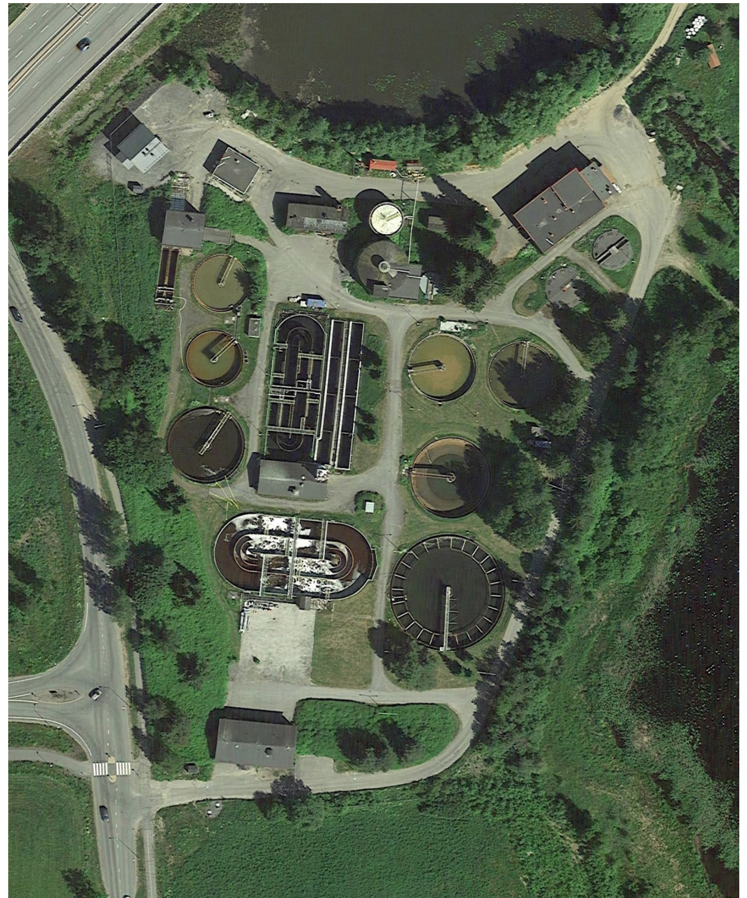
Kuva 1, Ilmakuva jätevedenpuhdistamon alueesta
