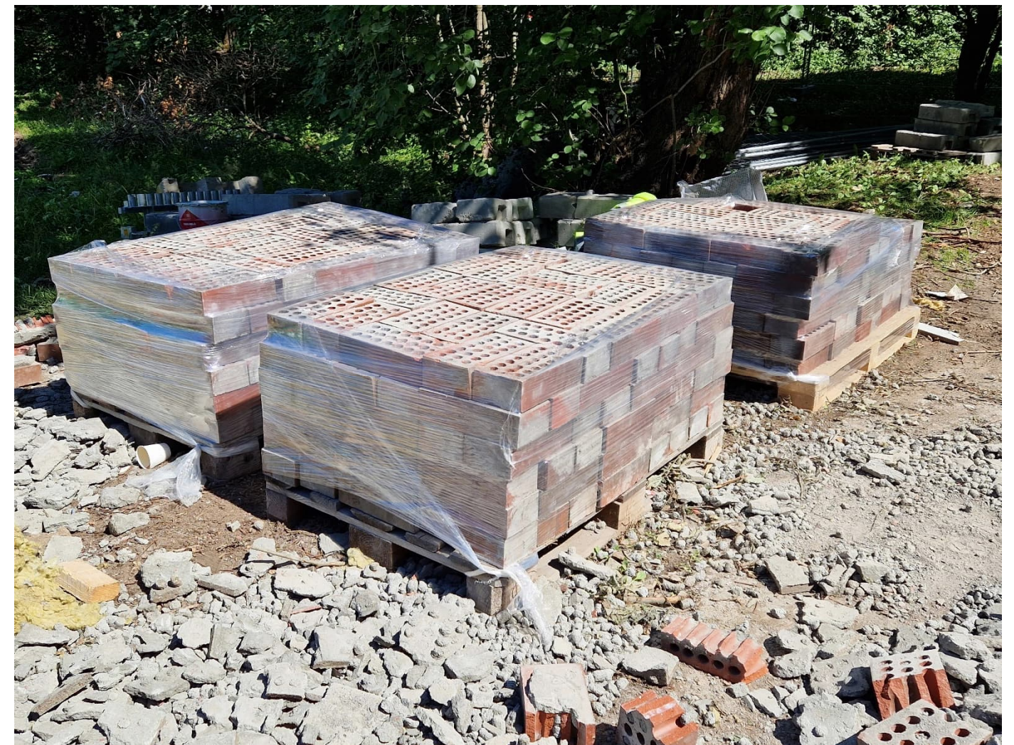
Kuva 9, Tiilet tulee lajitella rakennuksen julkisivun sekä tiilityypin mukaan jäljitettävyyden takaamiseksi.
