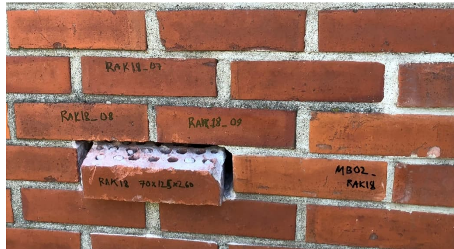
Kuva 8, Rakennuksen 18 pohjoisjulkisivun näytteenottopaikka
