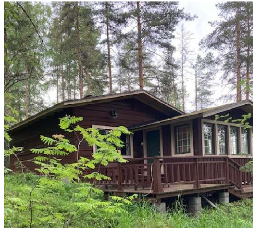
Talousrakennukseksi muutettava lomarakennus 102877139C Kelmanninsaarella.
