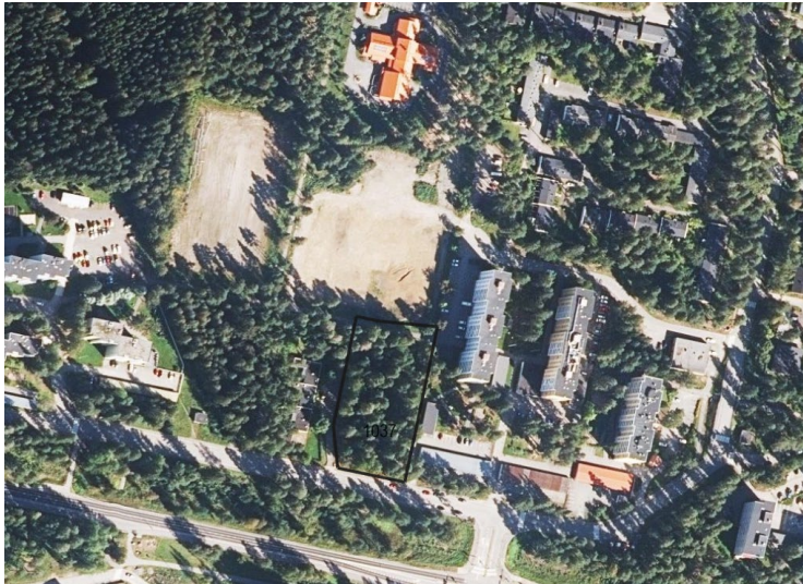
Kuva: Ilmakuva suunnittelualueesta ja sen lähiympäristöstä. Kuvassa hahmottuu ympäröivää kaupunkikuvaa ja rakennettua ympäristöä.
