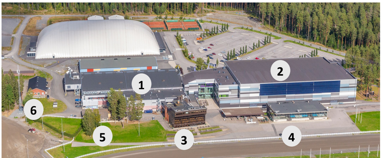
KUVA 3 Suunnittelualan rakennuksia kuvattuna lännestä.
