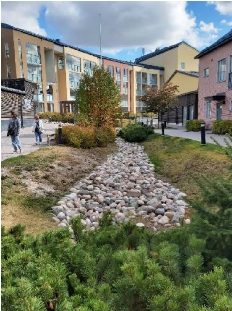
Kuva 12. Esimerkkikuva hulevesipainanteesta (Ramboll)
