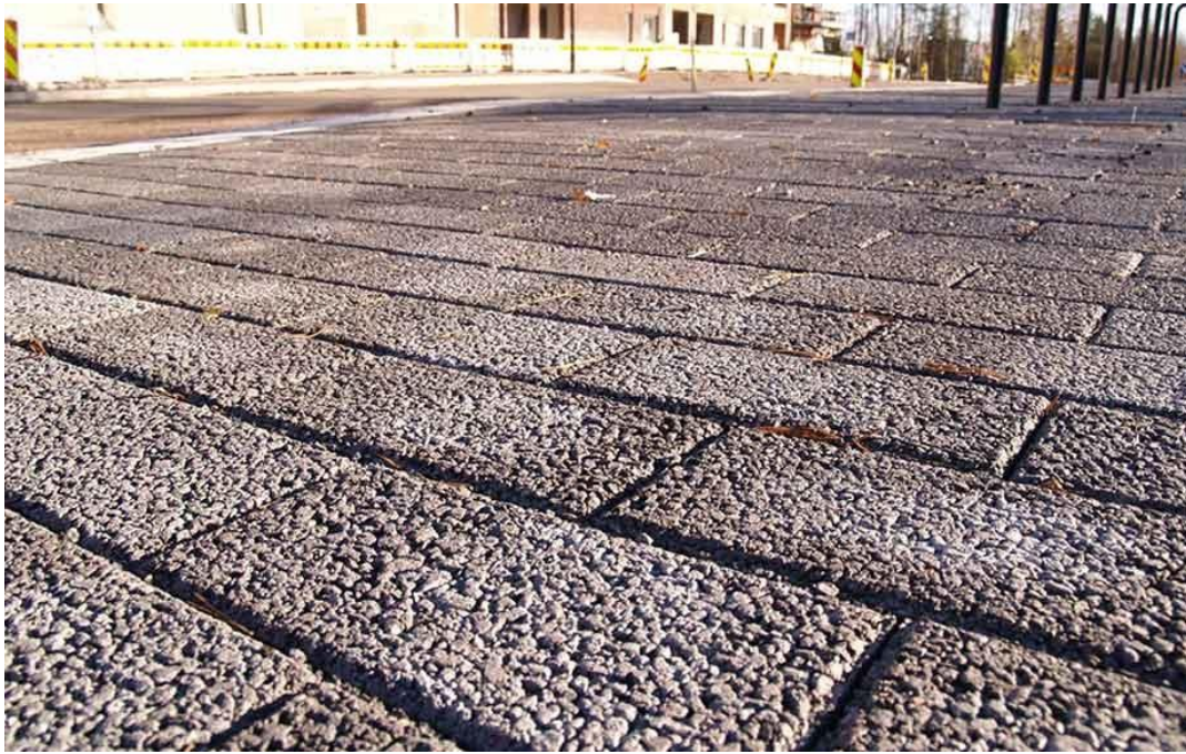
Kuva 13. Esimerkki läpäisevästä kivetyksestä (Rudus)
