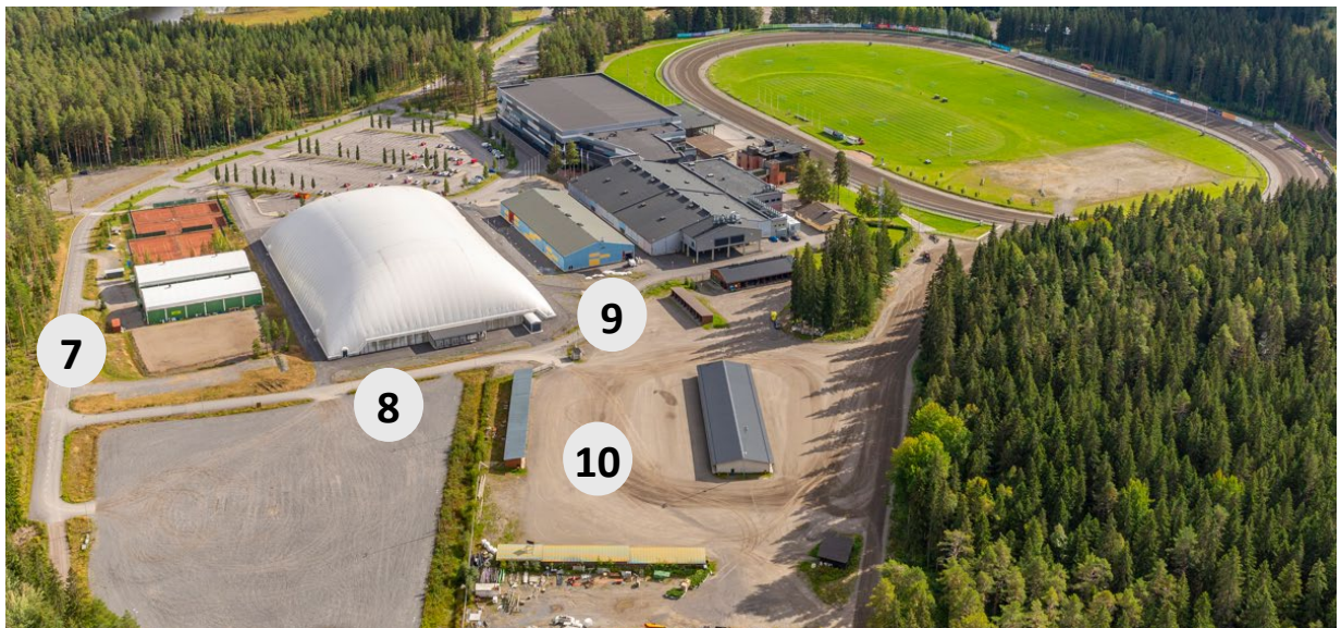
Kuva 4 Sunnittelualueen rakennuksia kuvattuna pohjoisesta.
