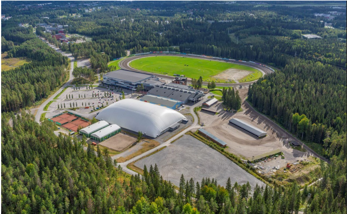
KUVA 1 Suunnittelualue pohjoisesta kuvattuna
