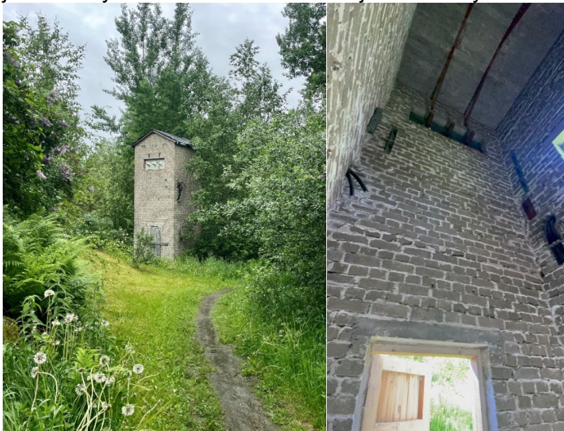
Tornimuuntamorakennus ulkoa ja sisältä kuvattuna.
