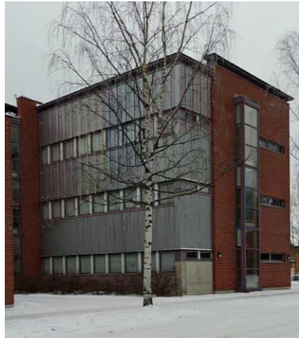
Kuvat 38. Itä- ja länsisiipien päädyt Jääkärintielle. Käytävien kohdalla on lasiseinä rakenteet, pihojen puolella peltikaseteilla verhoiltuja pintoja.
