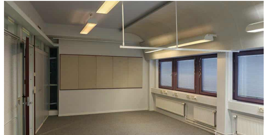
Kuva 54. Työhuone A331 eteläkäytävän varrella, sisäpihalle päin. Kaarevat alumiinikasetit ikkunoiden yläpuolella oikealla, taulu ja kaapistot vasemmalla ovat todennäköisesti alkuperäisiä.
