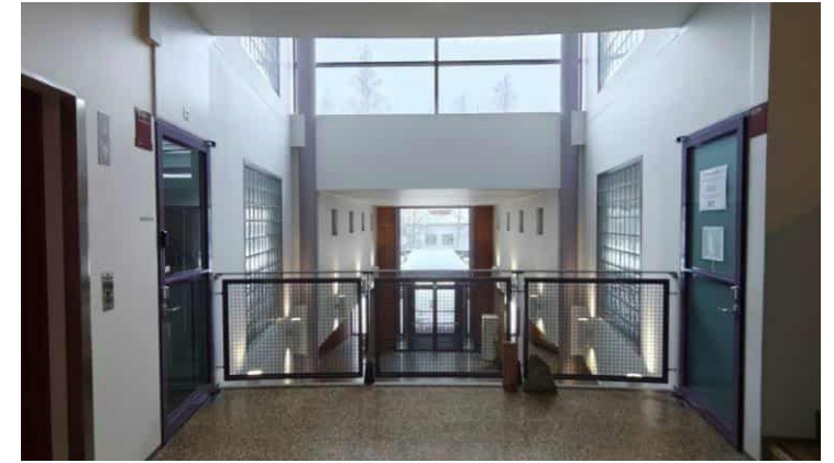
Kuva 74. Toisen kerroksen kerrostasanne pääportaan kohdalla, jossa on metalliverkkokaide. Pääportaita pitkin pääsee kellariin ja johtokunnan saunaosastoon.
