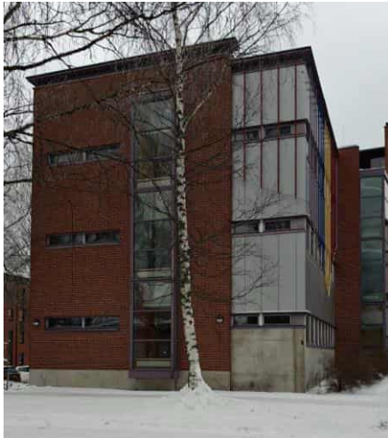
Kuvat 38. Itä- ja länsisiipien päädyt Jääkärintielle. Käytävien kohdalla on lasiseinä rakenteet, pihojen puolella peltikaseteilla verhoiltuja pintoja.
