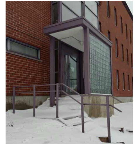
Kuva 33. Toistuva ikkunatyyppe: kiinteä korkea ikkuna, ja sivuosa, jonka edessä on reikätiili.
