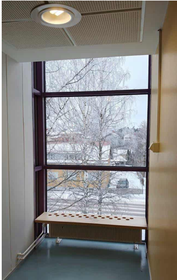
Kuva 69. Käytävän C319 pääty pohjoiseen. Kaikissa kerroksissa lasiseiniä edessä on patteri ja patterin yläpuolella koivupintainen rei'itetty puupenkki.
