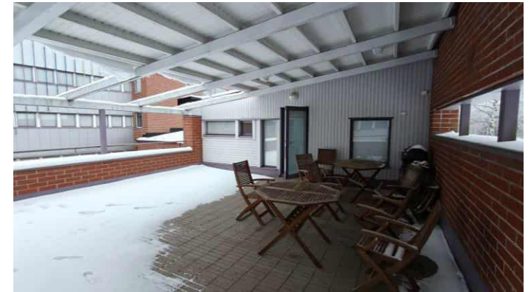
Kuva 75. Sivurakennuksen katettu terassi Jääkärintien puolella. Sivurakennuksen yläkerrassa on henkilökunnan saunatiloja.
