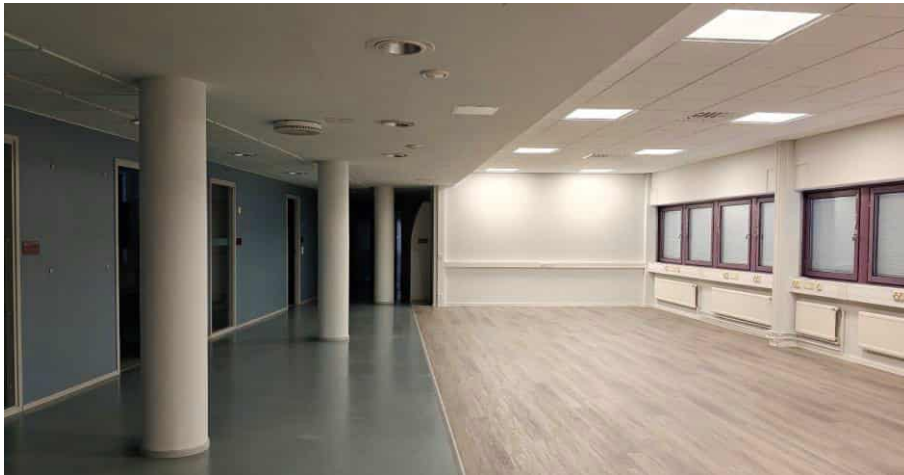
Kuva 59. Toisen kerroksen työtilat käytävän A222 varrella on muokattu työkahvilaksi ja liitetty avoimesti käytävätilaan. Väliseinät ja kaapistot on purettu 2020-luvun alussa.
