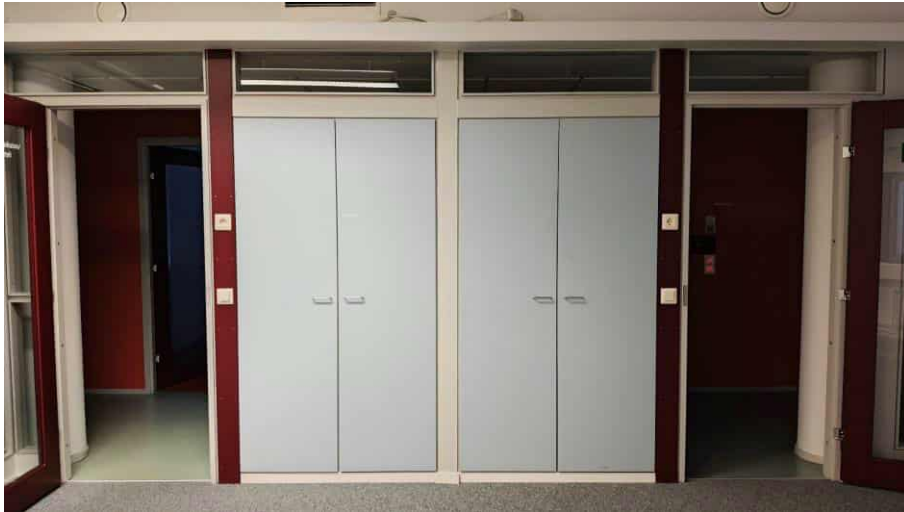
Kuva 55. Tilassa B118 sijaitseva kaapisto yläkunnoinen edustaa rakennukselle ominaista alkuperäistä kiintokalusteratkaisua.
