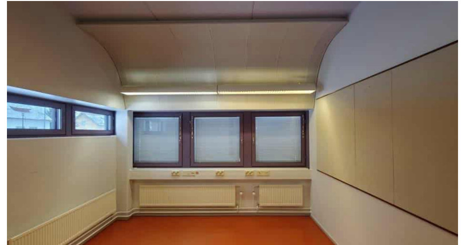
Kuva 53. Rakennuksen luoteiskulman tila A106 sisäpihan puolella. Ikkunatyypin ja kaarevat alumiinikasetit ovat tilatyypille ominaisia.
