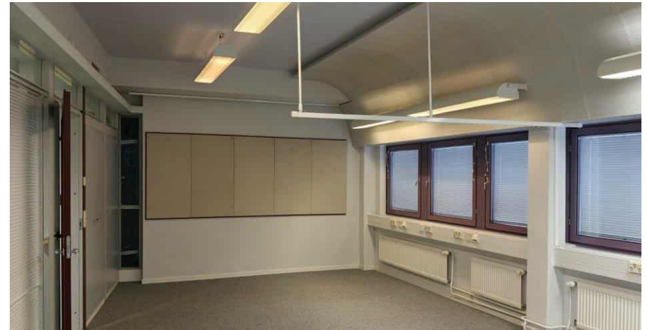
Kuva 54. Työhuone A331 eteläkäytävän varrella, sisäpihalle päin. Kaarevat alumiinikasetit ikkunoiden yläpuolella oikealla, taulu ja kaapistot vasemmalla ovat todennäköisesti alkuperäisiä.
