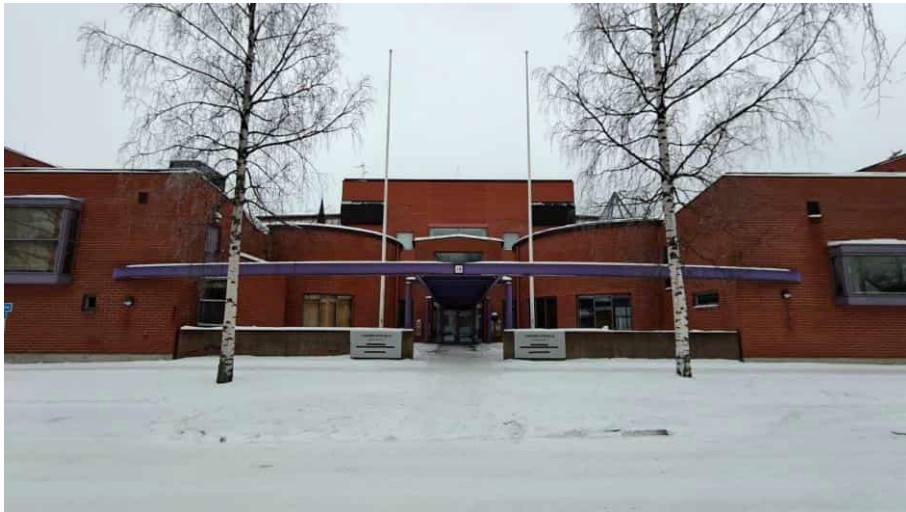
Kuva 36. Pohjoisjulkisivu ja pääsisäänkäynti.
