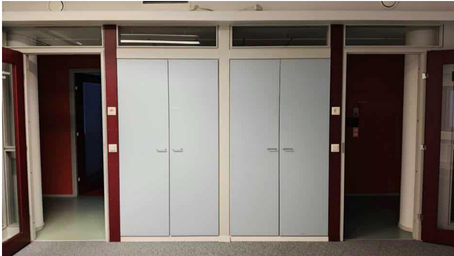
Kuva 55. Tilassa B118 sijaitseva kaapisto yläkkuineen edustaa rakennukselle ominaista alkuperäistä kiintokalusteratkaisua.
