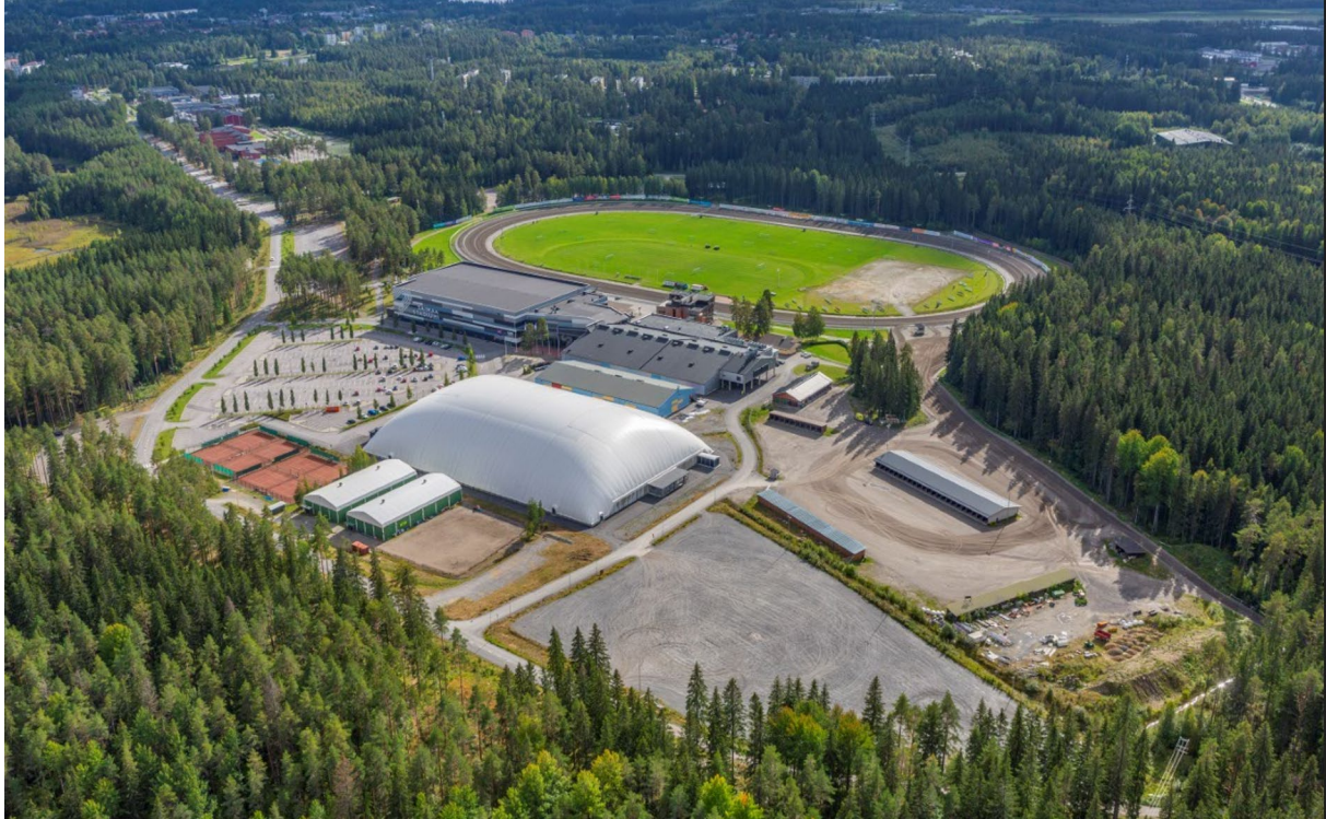
KUVA 1 Suunnittelualue pohjoisesta kuvattuna
