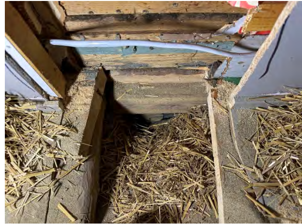
Kuva 73. Alapohjan eristeenä olkea, hiekkaa, turvetta yms.
