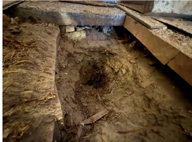
Kuva 31. Alapohjan täyttöä.
