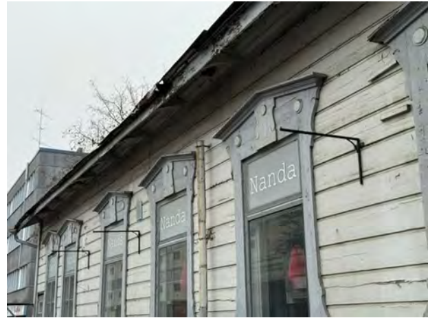
Kuva 45. Rästäsrakenteiden lahovaurioita.
