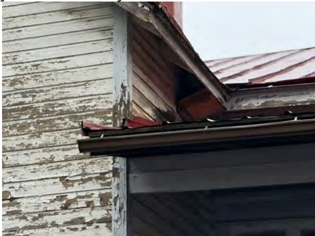
Kuva 36. Julkisivun yläreunaa ja katon liitoksia.
