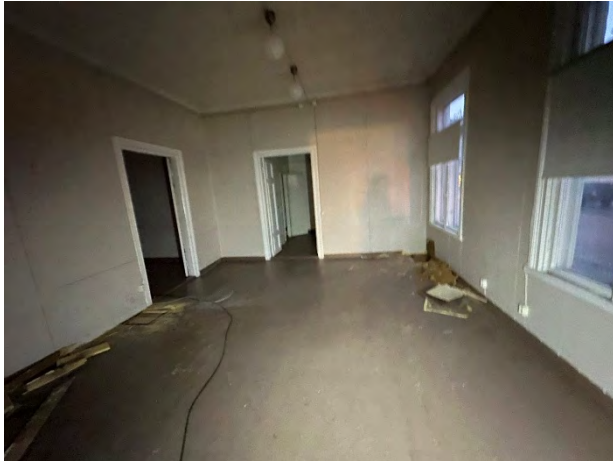
Kuva 52. Yleiskuvaa rakennuksen sisätiloista.
