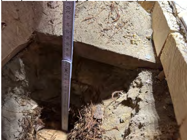
Kuva 28. Alapohjan eristepaksuus on n. 260 mm
