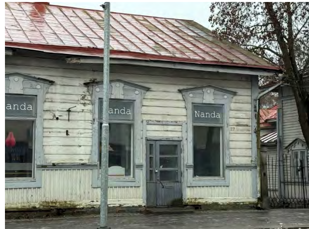
Kuva 47. Vesikattoa ja rästäsrakenteita.
