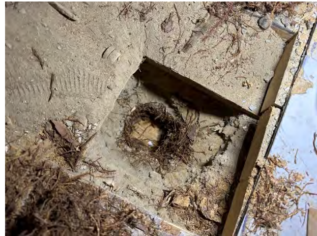
Kuva 27. Alapohjan eristeenä on hiekkaa, turvetta, sammalta, purua yms.
