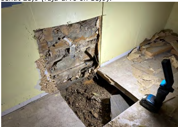
Kuva 64. Avattua ulkoseinärakennetta, ulkoseinien sisäkuorissa on osittain sisäpuolisia rakennekerroksia.
