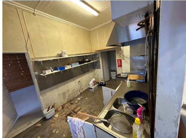
Kuva 11. Yleiskuvaa rakennuksen sisätiloista.
