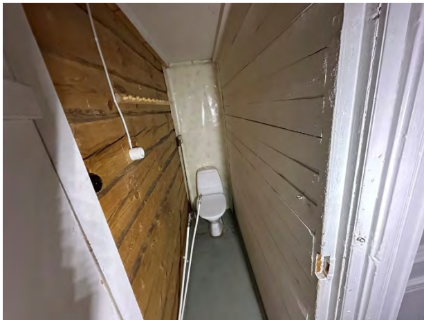
Kuva 54. Yleiskuvaa rakennuksen sisätiloista.
