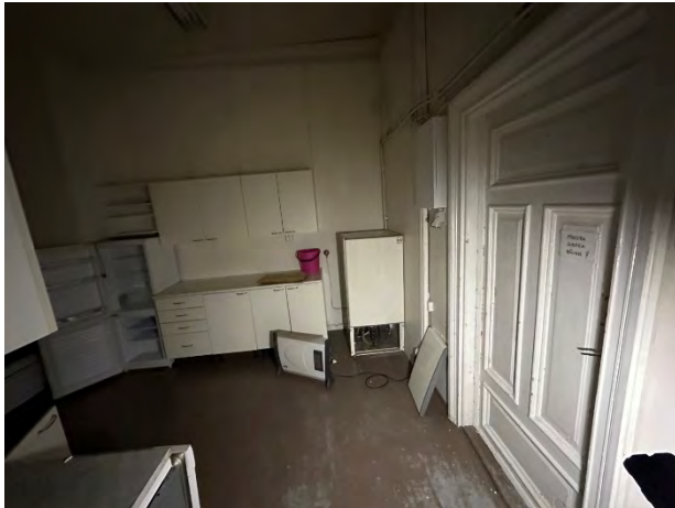
Kuva 56. Yleiskuvaa rakennuksen sisätiloista.
