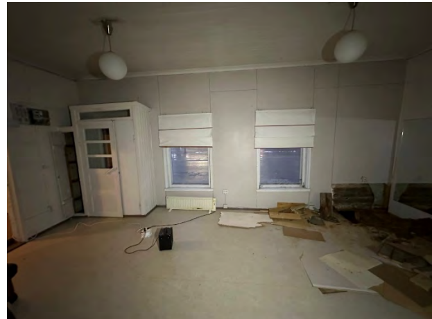
Kuva 49. Yleiskuvaa rakennuksen sisätiloista.
