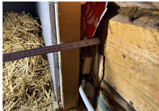
Kuva 65. Ulkoseinän sisäpuolista rakennetta.
