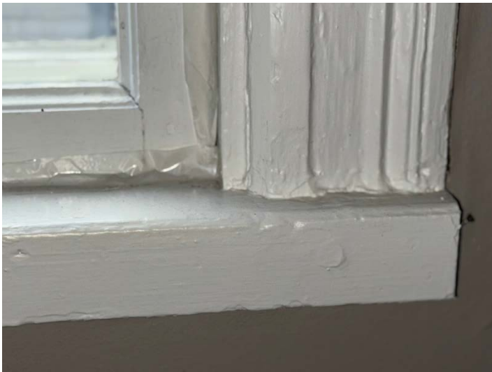
Kuva 34. Vanhaa listoitusta, jota on säilynyt vain muutamissa ikkunoissa.
