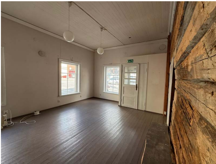
Kuva 44. Kulman huonetila, joka on rakennuksen vanhin osa.
