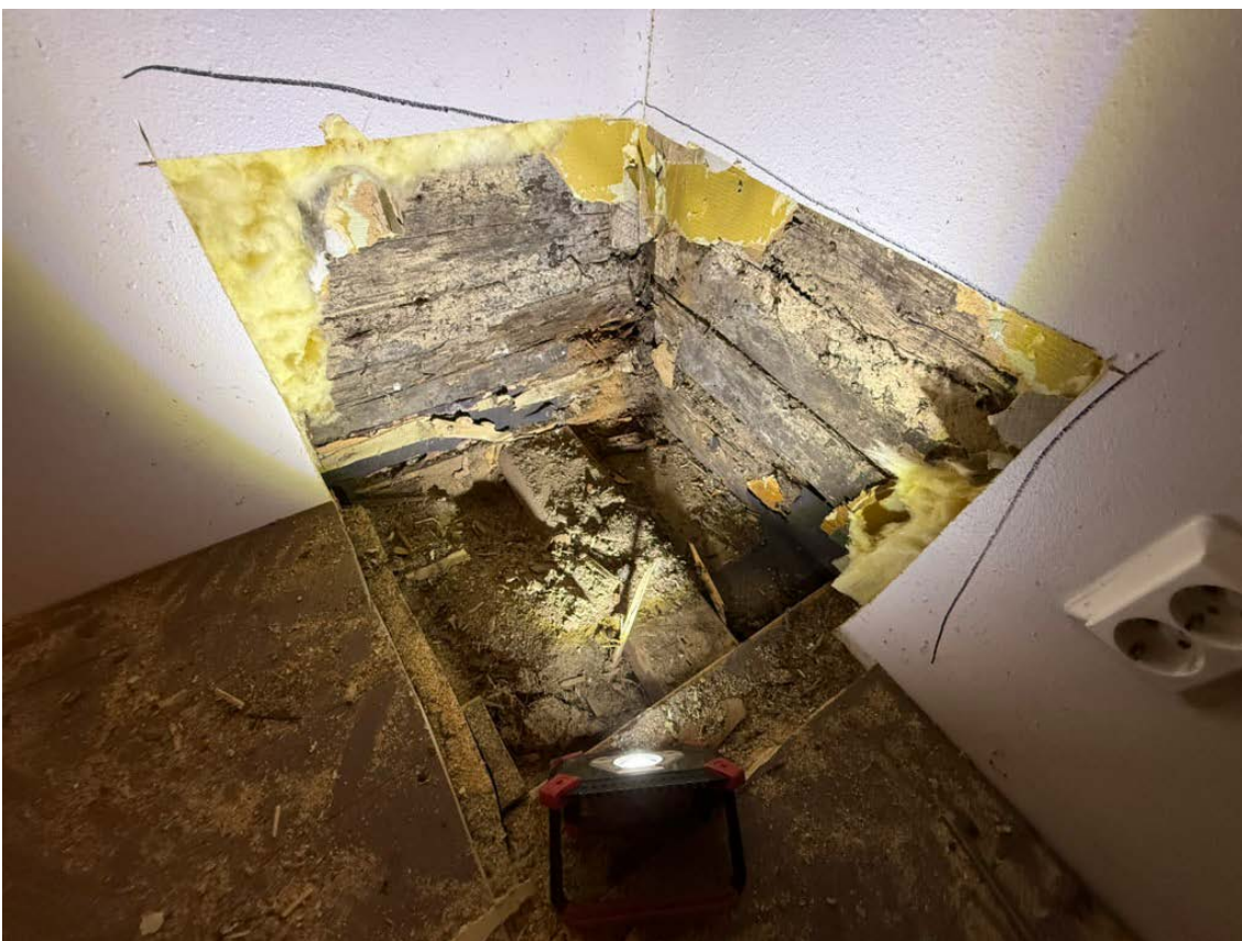
Kuva 26. Vanhin kulmaus, jossa hirsirakenne vuodelta 1843.
