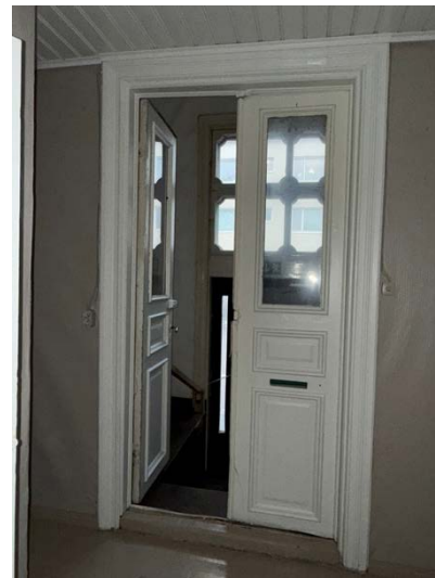
Kuva 39. Mikonkatu sisäänkäynti vanhempi ovi säilynyt.
