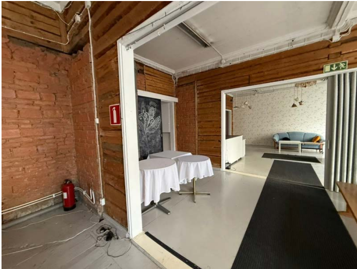
Kuva 42. Sisätilat pelkistetty kahvilakäyttöön.
