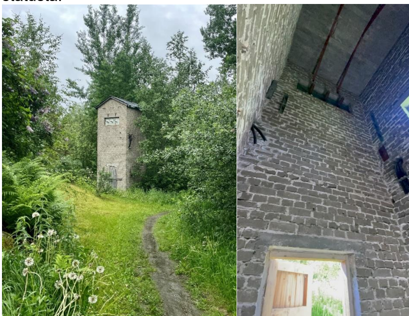
Tornimuuntamorakennus ulkoa ja sisältä kuvattuna.
