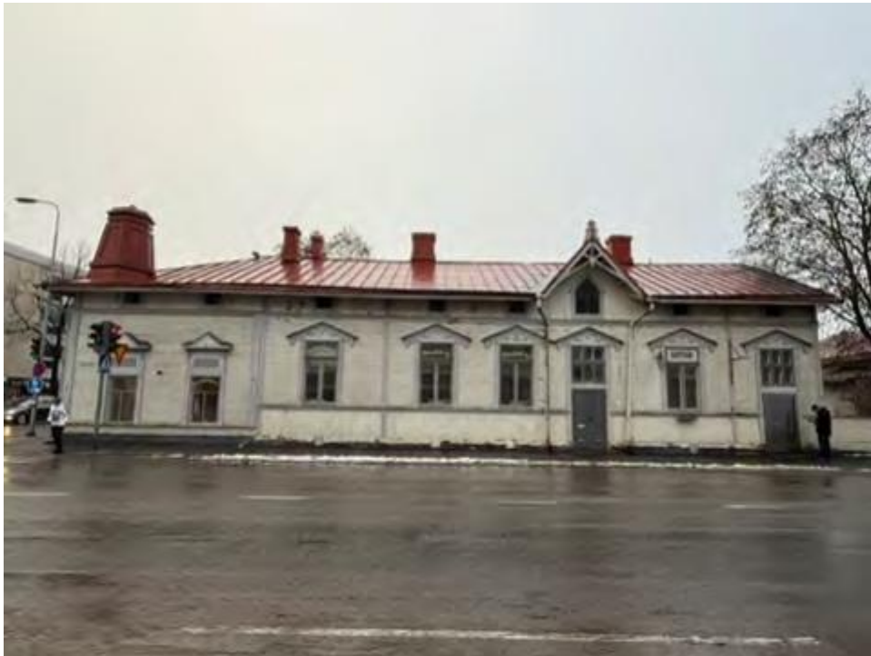
Kuva 7. Talon 2 julkisivu Mikonkadun suunnasta
