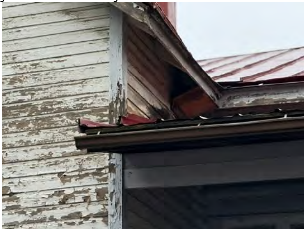
Kuva 36. Julkisivun yläreunaa ja katon liitoksia.
