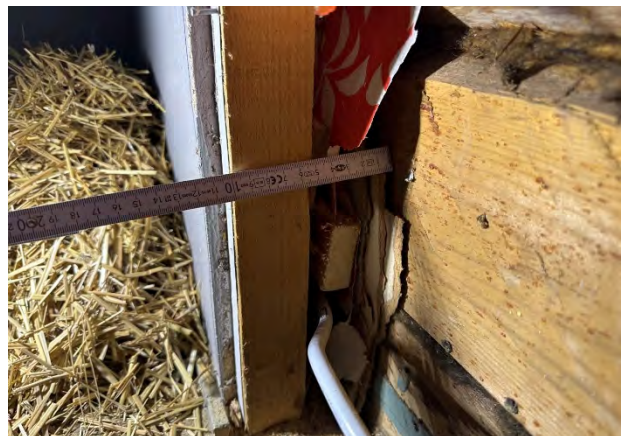
Kuva 65. Ulkoseinän sisäpuolista rakennetta.
