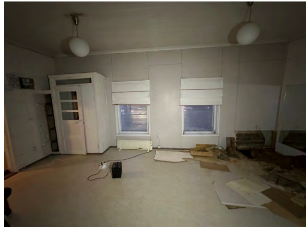
Kuva 49. Yleiskuvaa rakennuksen sisätiloista.
