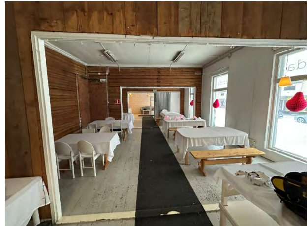
Kuva 7. Yleiskuvaa rakennuksen sisätiloista.
