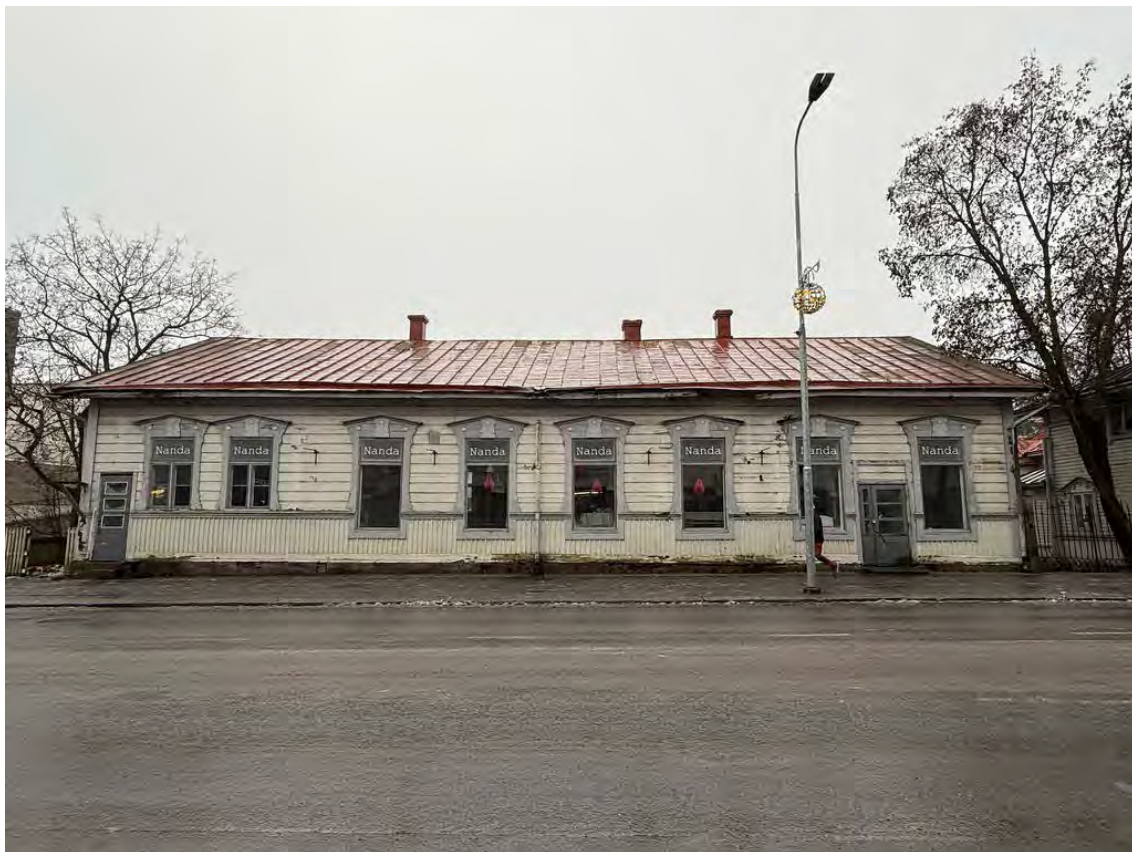
Kuva 41. Savilahdenkadun puoleinen katujulkisivu, Savilahdenkatu 12. Kuva joulukuulta 2025.
