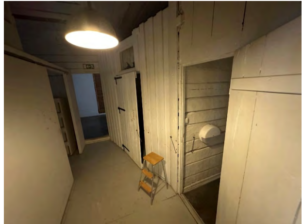
Kuva 15. Yleiskuvaa rakennuksen sisätiloista.
