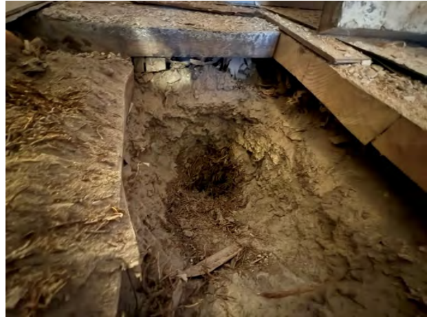
Kuva 31. Alapohjan täyttöä.
