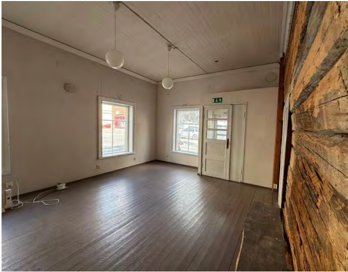
Kuva 30. Kulmatalon huonetila. Huone on rakennuksen vanhin osa. Mikonkadun kulma. Kuva 2025.
