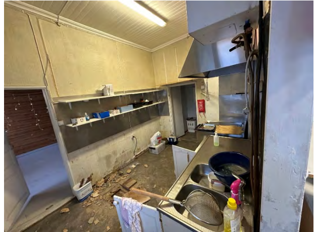
Kuva 11. Yleiskuvaa rakennuksen sisätiloista.
