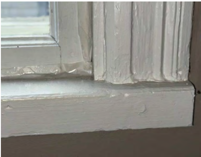
Kuva 24. Kulmatalon Mikonkadun puoleisissa ikkunoissa säilynyttä vanhaa listoitusta. Vastaavaa listoitusta on säilynyt vain muutamissa ikkunoissa. Kuva 2025.
