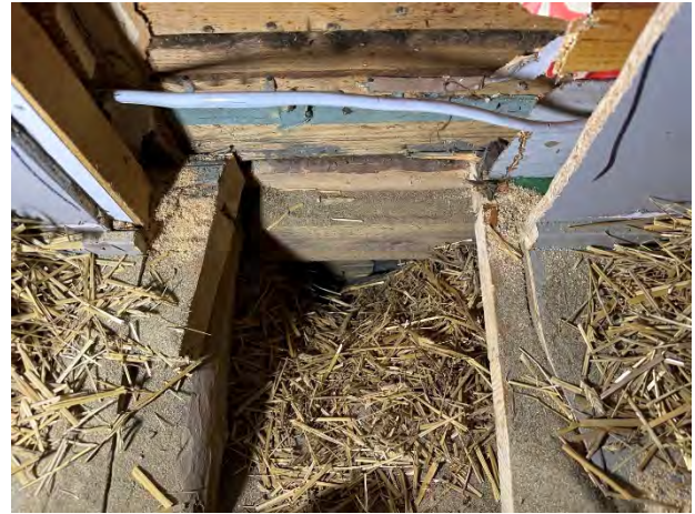
Kuva 73. Alapohjan eristeenä olkea, hiekkaa, turvetta yms.
