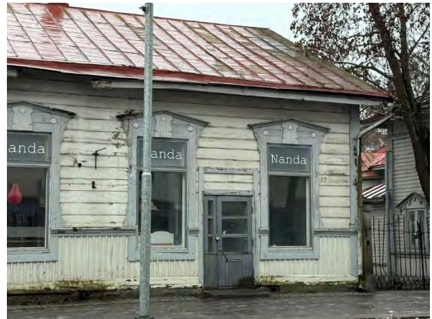
Kuva 47. Vesikattoa ja räystäsra-kenteita.
