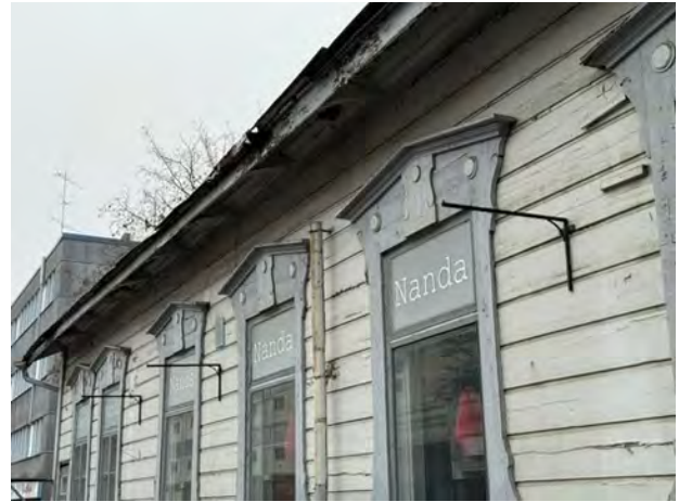
Kuva 45. Räystäsra-kenteiden lahovaurioita.
