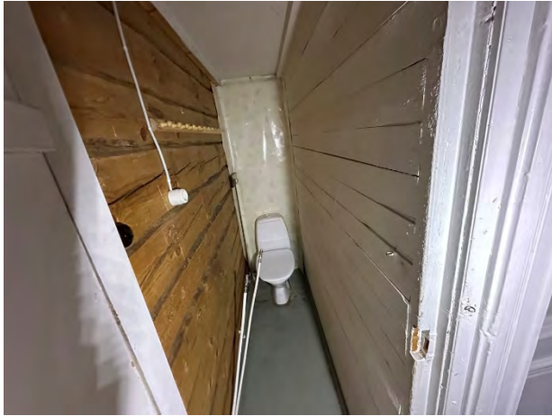
Kuva 54. Yleiskuvaa rakennuksen sisätiloista.
