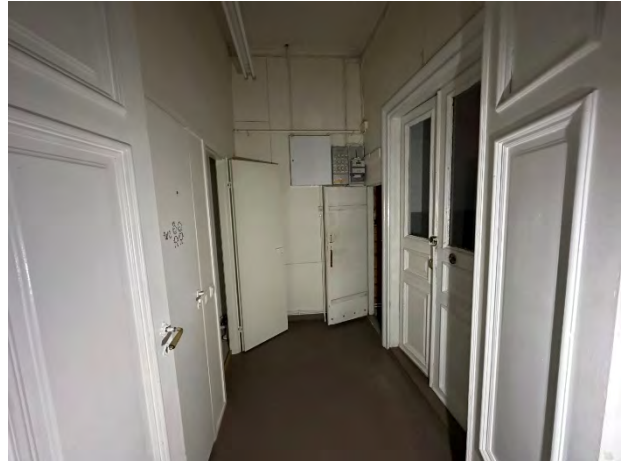
Kuva 53. Yleiskuvaa rakennuksen sisätiloista.
