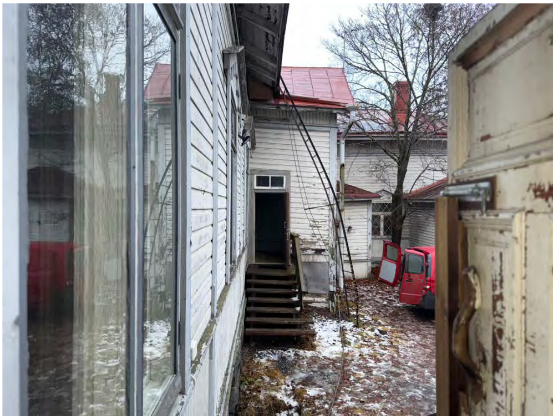
Kuva 20. Sisäpihan sisäänkäyntejä Mikonkadun puolella. Kuva 2025.
