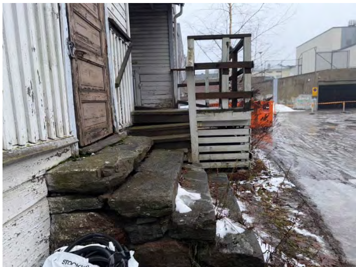
Kuva 48. Sisäpihan kiviportaikko Savilahdenkatu 12:ssa. Kuva 2025.
