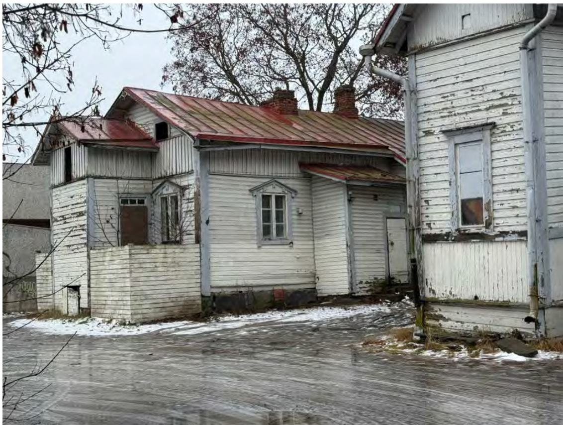
Kuva 50. Leivintupa pihajulkisivu Mikonkadulla keväällä 2025
