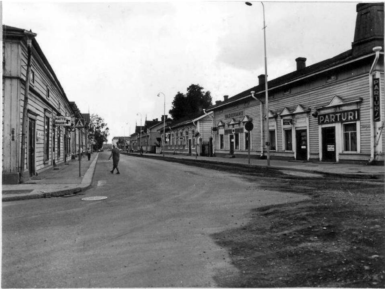
Kuva 35. Vuonna 1973 Savilahdenkadulta otettu kuva kertoo, että Pulkkisenkulma oli aikoinaan osa yhtenäistä kaupunkikeskustarakentamista. Savilahdenkatu 12 varrella sijaitseva toinen päärakennus valmistui vuonna 1875. Kuva Mikkelin kaupungin museot.
