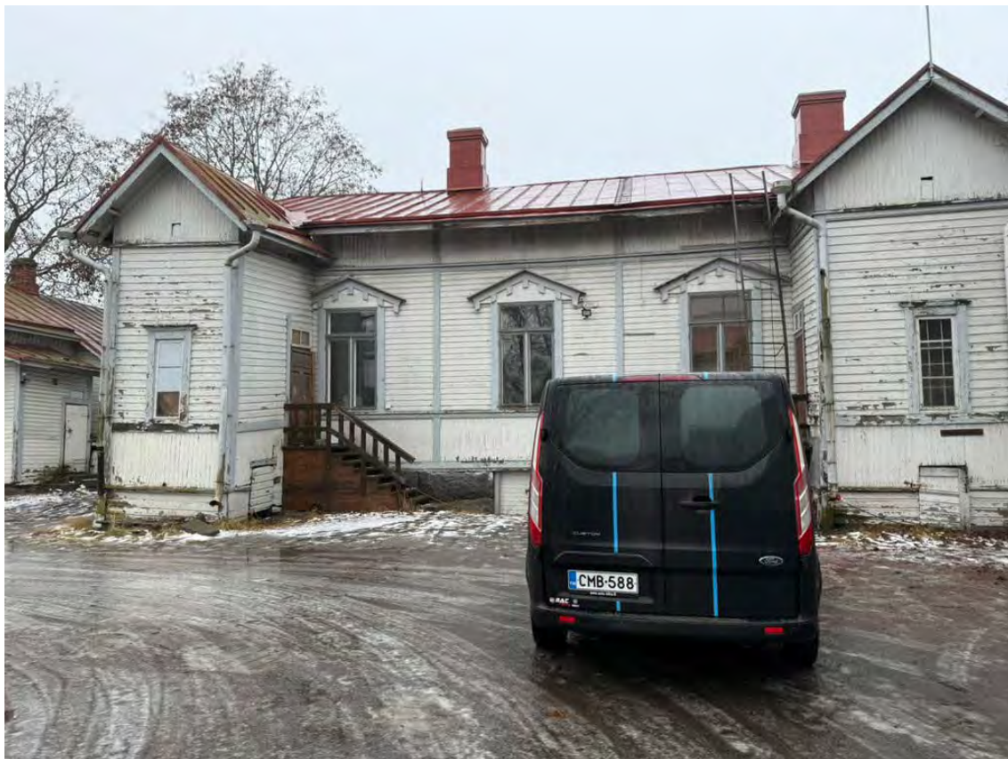
Kuva 19. Kulmatalon sisäpiha Mikonkadun puolella. Vasemmalla päädyssä viimeinen käytössä ollut tila, joka oli käytössä vuoden 2025 loppupuolelle saakka. Kuva 2025.
