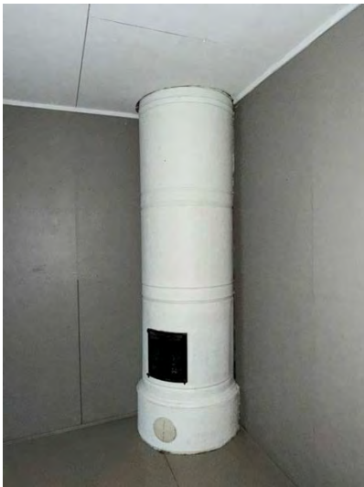
Kuva 28. Pönttöuunia ja nykyisiä lastulevyseiniä, Mikonkatu kulmatalo. Kuva 2025.
