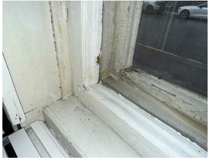
Kuva 27. Yksittäisiä vanhimpia ikkunoita Mikonkadulla. Kuva 2025.
