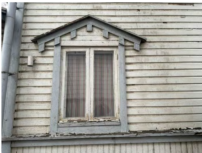
Kuva 55. Nykyistä ikkunalistoitusta leivintupa 2025
